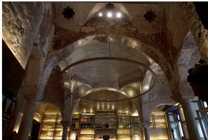
Figura 3.19. Cúpula sobre la barra del Bar Giralda, antigua sala templada.
