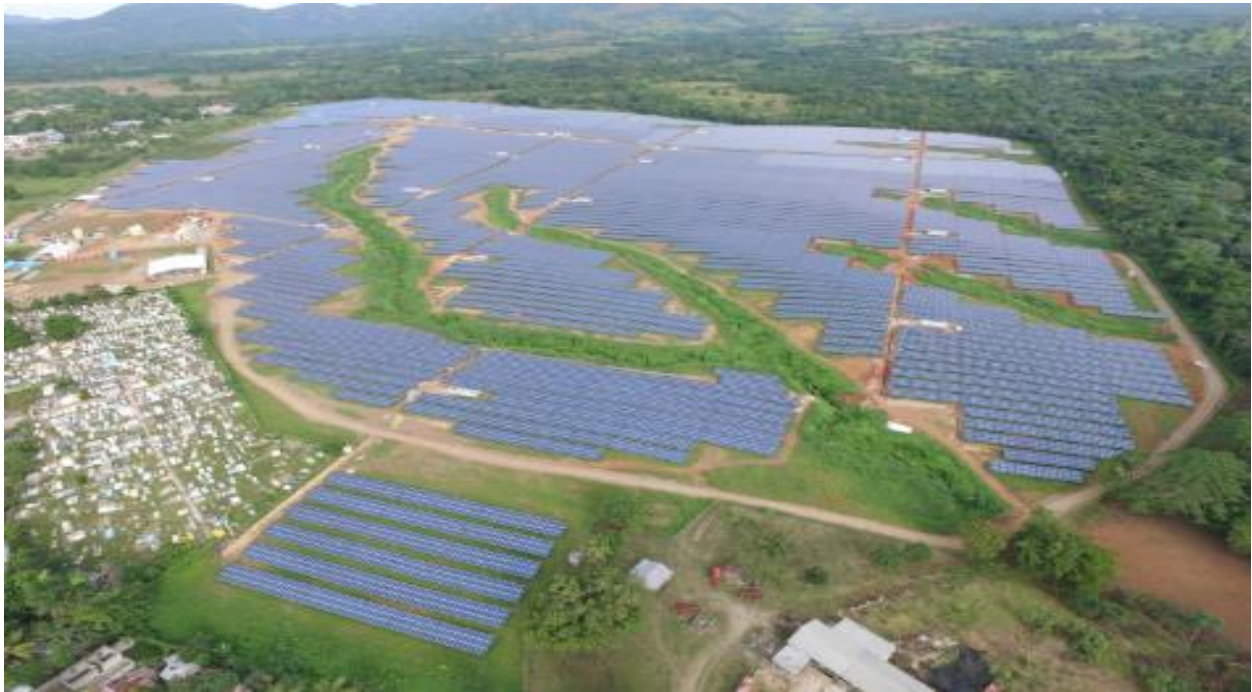
Fig. 29 Planta Fotovoltaica con Montaje Fijo
