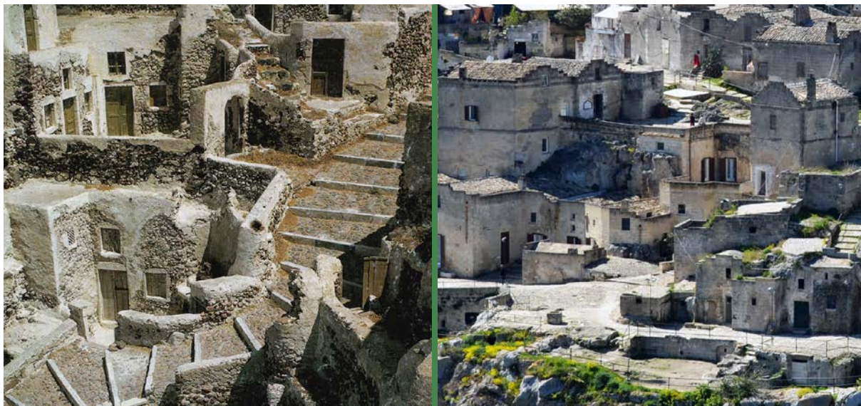
Figuras 14 e 15. Imágenes del conjunto de Matera. Tesis doctoral de Pisciotta, M. B. Architettura di sottrazione. Declinazioni e caratteri del processo di scavo per la definizione dello spazio. Università degli Studi della Basilicata.
