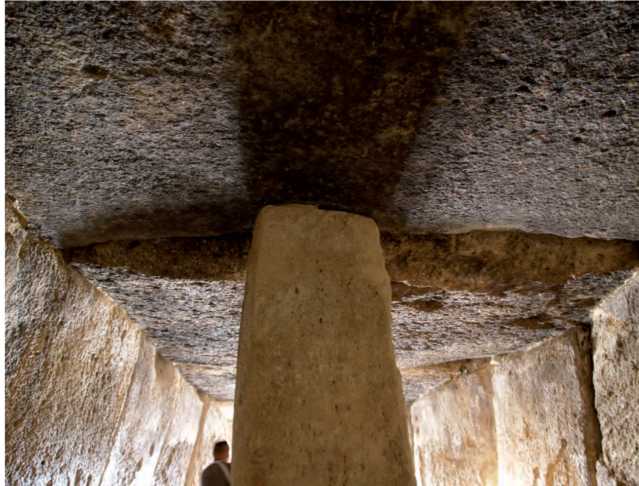
Parte superior del pilar situado al fondo de la cámara de Menga. Autor: Técnicas Documentales Tecnológicas, S.L.
