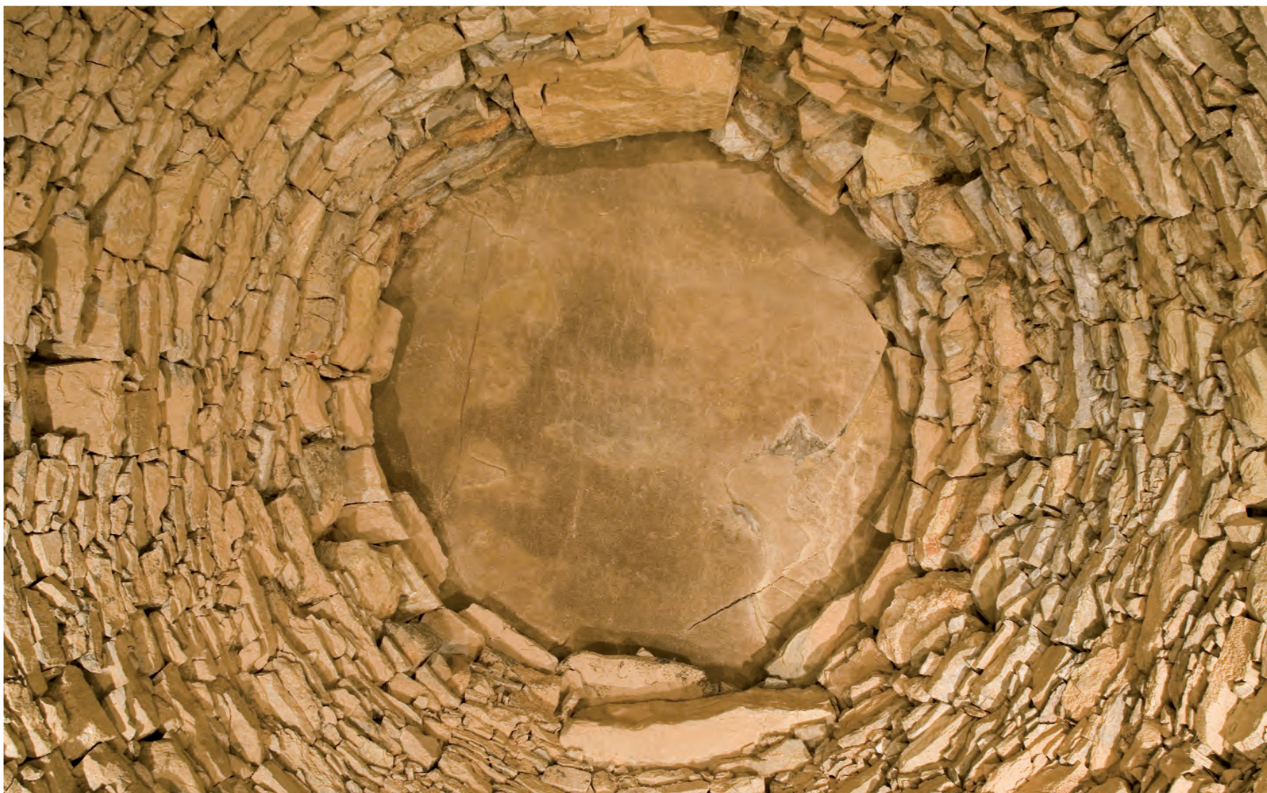
Gran losa que cierra la bóveda de la cámara del dolmen de El Romeral. Autor: Javier Pérez González.
