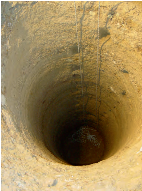
El pozo se localiza entre el último pilar y la losa de cierre de la cámara de Menga, y tiene un diámetro de 1,50 metros. Autor: Moreno Estudio Antequera.
