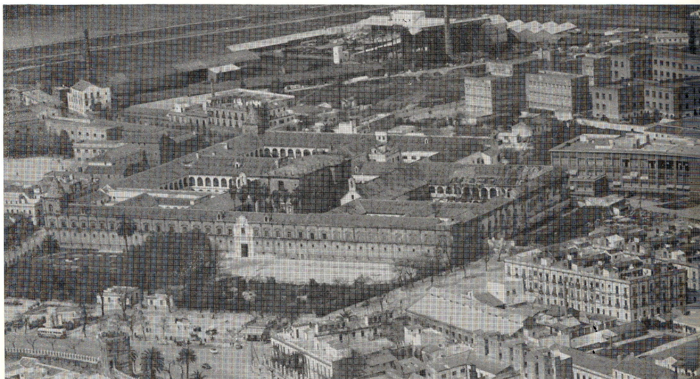
El Hospital antes de los últimos derrumbos
