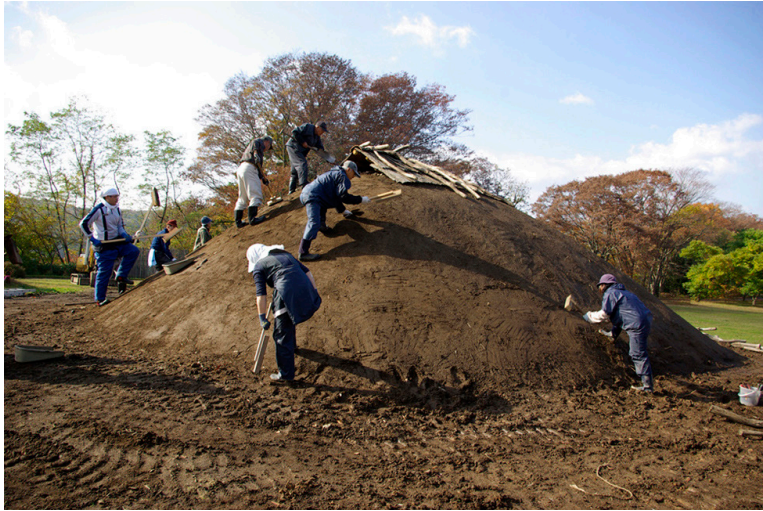
Fig. 13. Construcción de la techumbre del edificio satoyama, una vivienda jōmon en el parque arqueológico de Goshono. (Fotografía: Goshono Jōmon Park 27 ).
