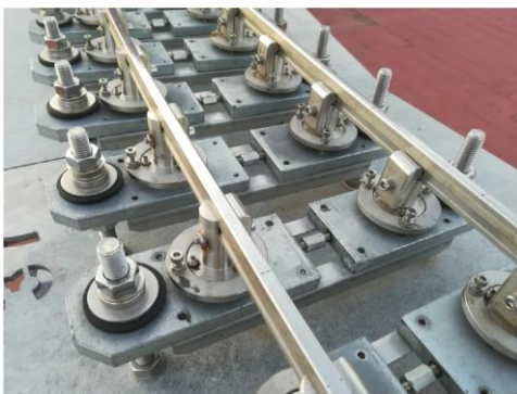
Figura 2-9. Detalle de los raíles y mecanismos de la vía
