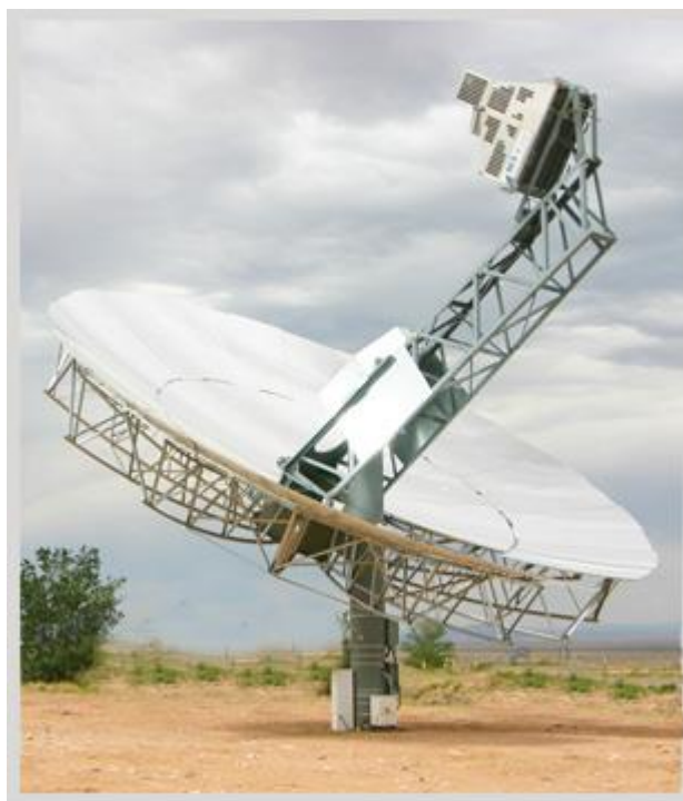
Figura 2.6. Disco parabólico (SunCatcher™). [13]
