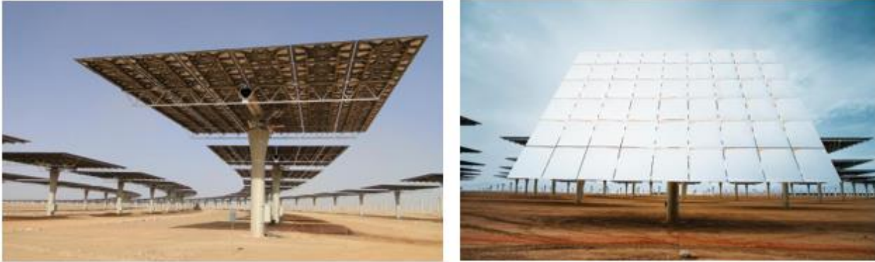
Figura 2.11. Heliostato de Noor III en Marruecos. [17]
