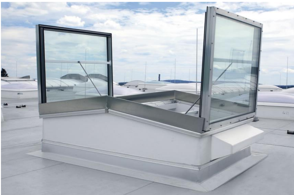
Ilustración 7: Exutorio de compuerta sobre lucernario
