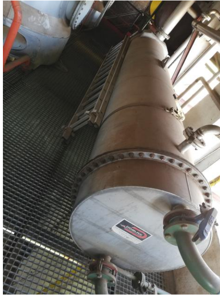
Figura 10: Condensador de vapores
