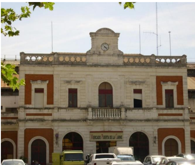
Imagen 13. Pabellón central de la antigua estación de San Bernardo de Sevilla, convertido en sede del Mercado Puerta de la Carne.
