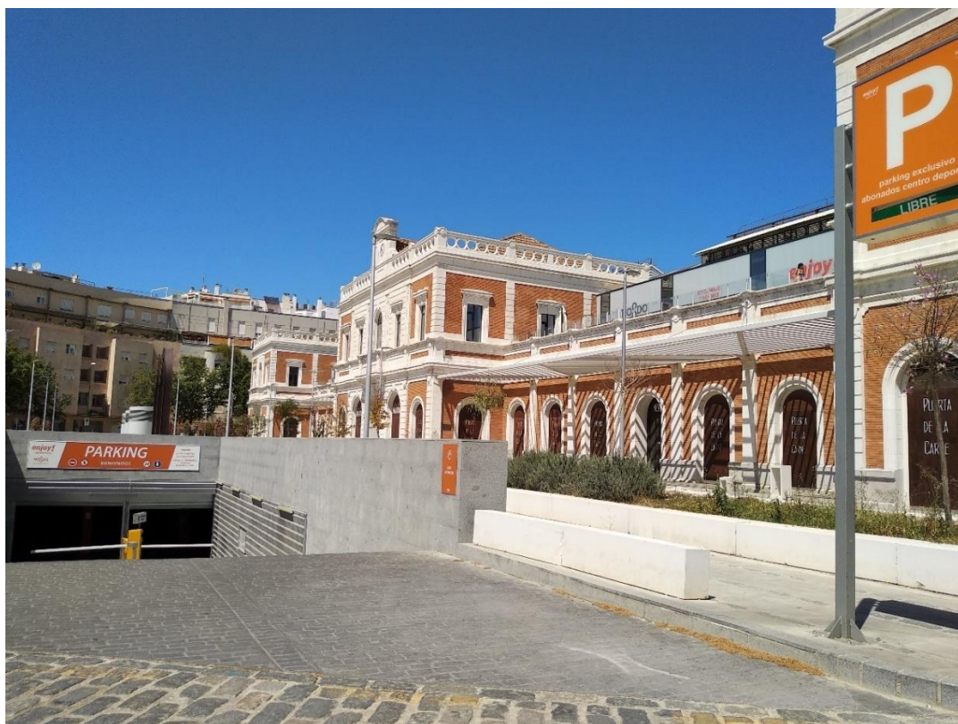
Imagen 22. Vista del nuevo parking subterráneo en la plaza del Mercado de la Carne. Fuente: Propia
