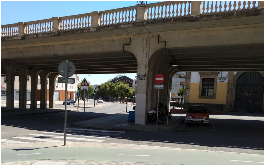
Imagen 26. Vista del entorno de la actual estación de San Bernardo. Fuente: Propia.
