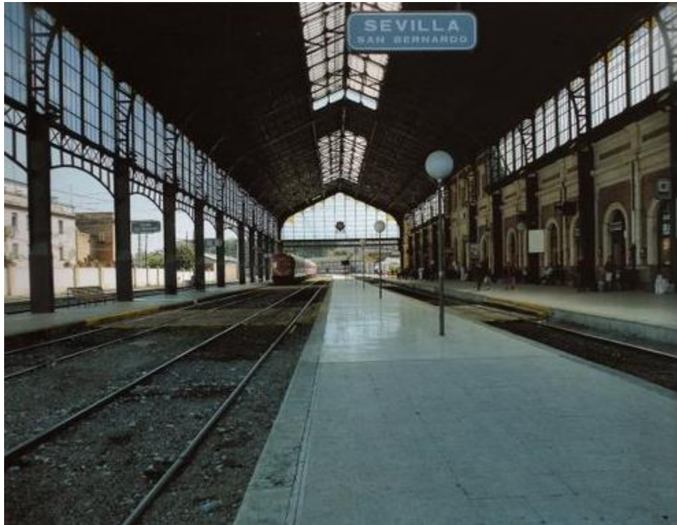
Imagen 11. Imagen de los andenes de la estación de San Bernardo. Fuente: Alquiansa.
