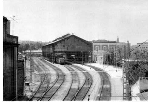
Imagen 9. Vista de las vías de la estación de San Bernardo, 1907. Fuente: Alquiansa
