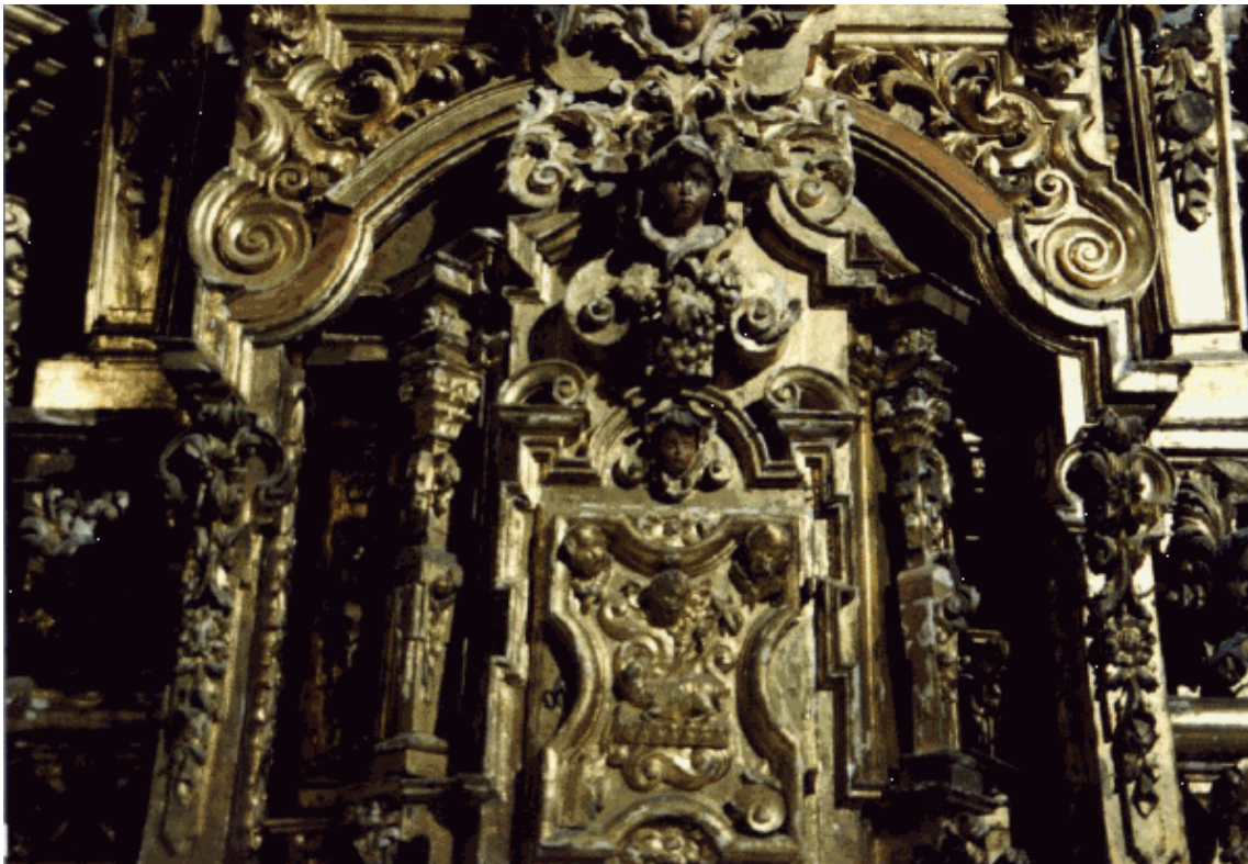
Vista general del Sagrario; se aprecia la falta de piezas en la moldura superior y los estípites.
