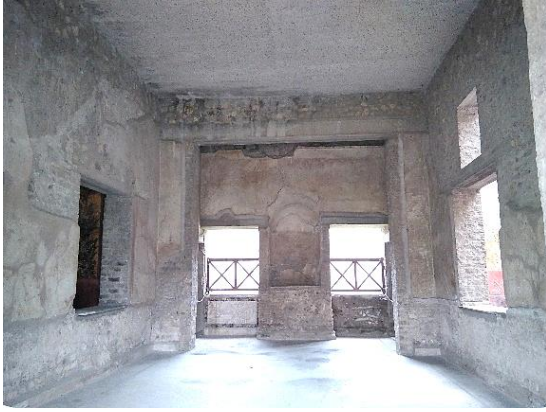
Imagen 87: [B9] Salón. Vista general
