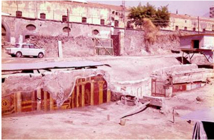
Imagen 17: Proceso de las excavaciones, agosto 1966
