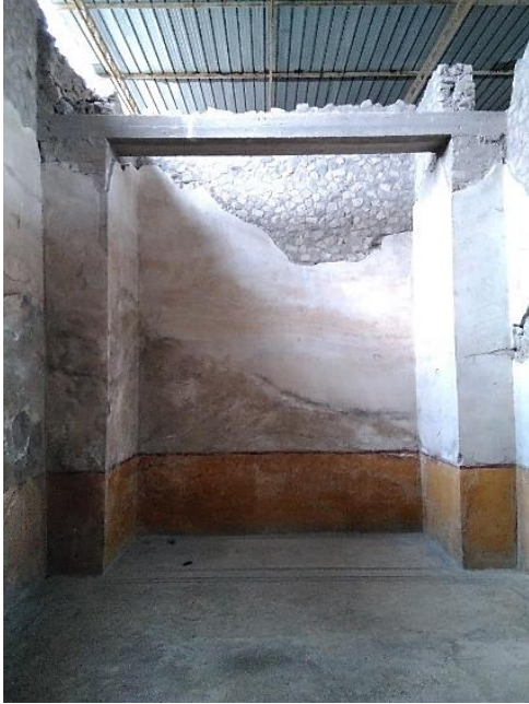
Imagen 93: [H7] Sala. Vista general
