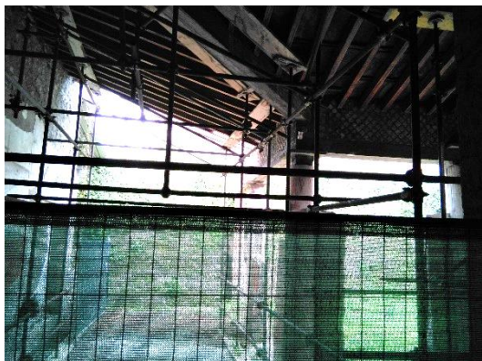
Imagen 105: [C1] Pasillo jardín en obras
