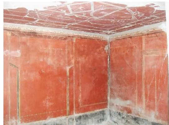
Imagen 61: [H5] Vista general
