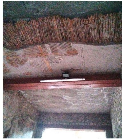
Imagen 71: [C3] Detalle. Recolocación de pinturas en el techo
