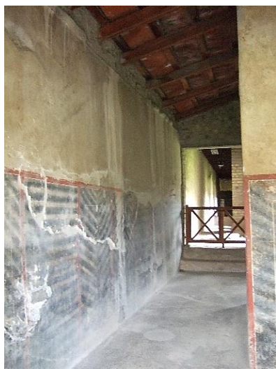
Imagen 85: [P10] Pasillo. Vista general
