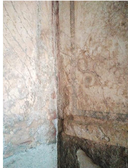
Imagen 65: [B8] Detalle. Marcas de ampollas y quemaduras
