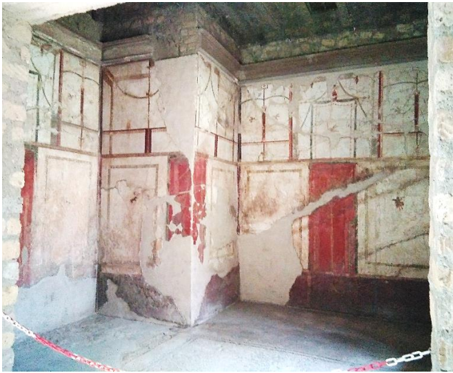
Imagen 64: [B8] Salón estivo. Vista general
