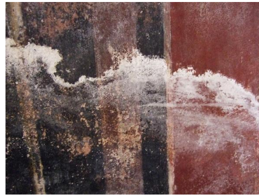
Imagen 47: [B4] Detalle. "Ola" de sales en pared Norte
