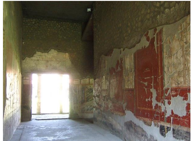
Imagen 77: [C6] Corredor Sur. Vista General
