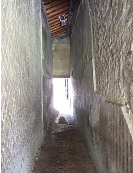
Imagen 32: [P1] Pasillo de entrada. Vista general
