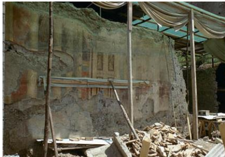
Imagen 20: Consolidación de los muros
