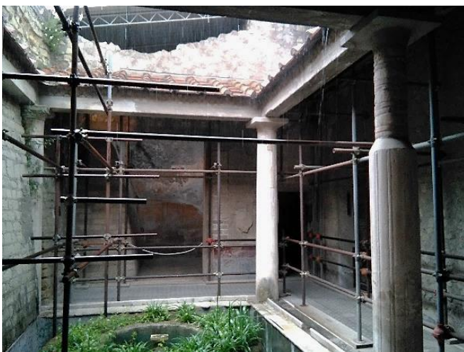
Imagen 42: [F1] Peristilo sector termal. Vista general
