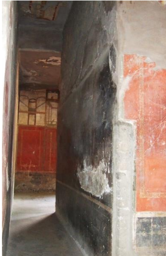
Imagen 80: [P8] Vista general, pasillo
