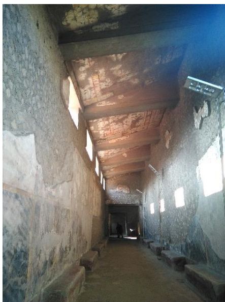
Imagen 72: [C4] Corredor E-O. Vista general
