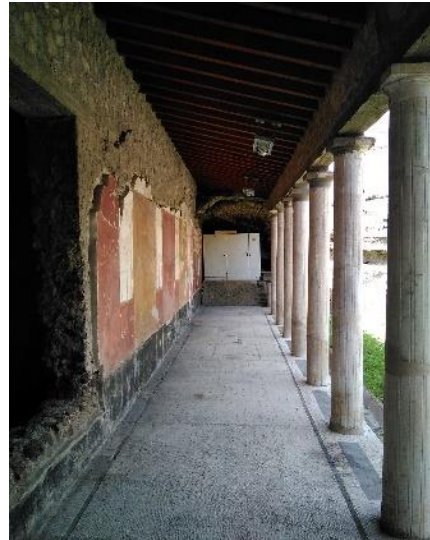
Imagen 29: [I1] Peristilo de entrada. Vista general interior
