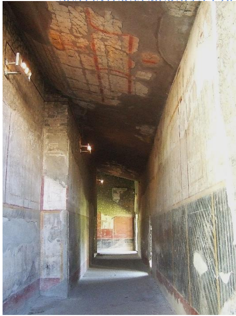
Imagen 74: [C5] Corredor N-S. Vista general
