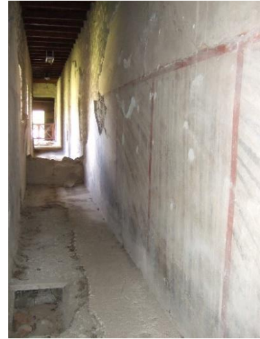
Imagen 100: [P6] y [P11] Vista general
