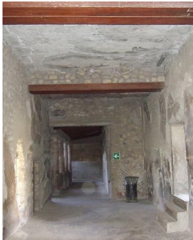
Imagen 70: [C3] Entrada corredor. Vista general
