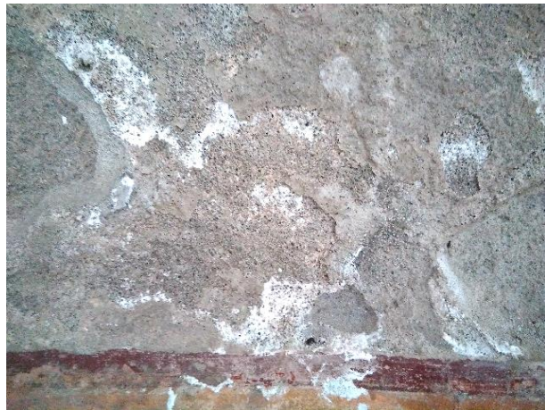
Imagen 94: [H7] Detalle. Ampollas, marcas y levantamientos de p. pictórica
