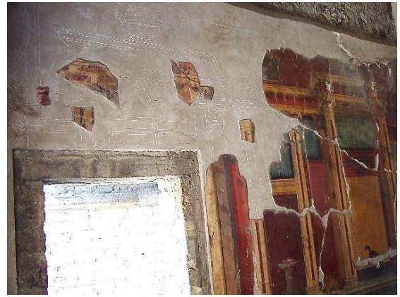
Imagen 63: [B7] Detalle. Reconstrucción de mortero con incisión del dibujo
