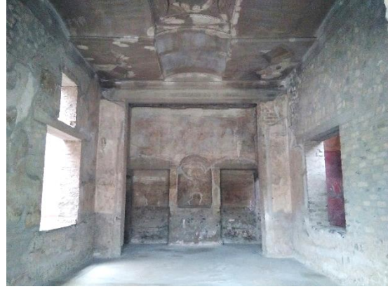
Imagen 88: [B10] Salón. Vista general
