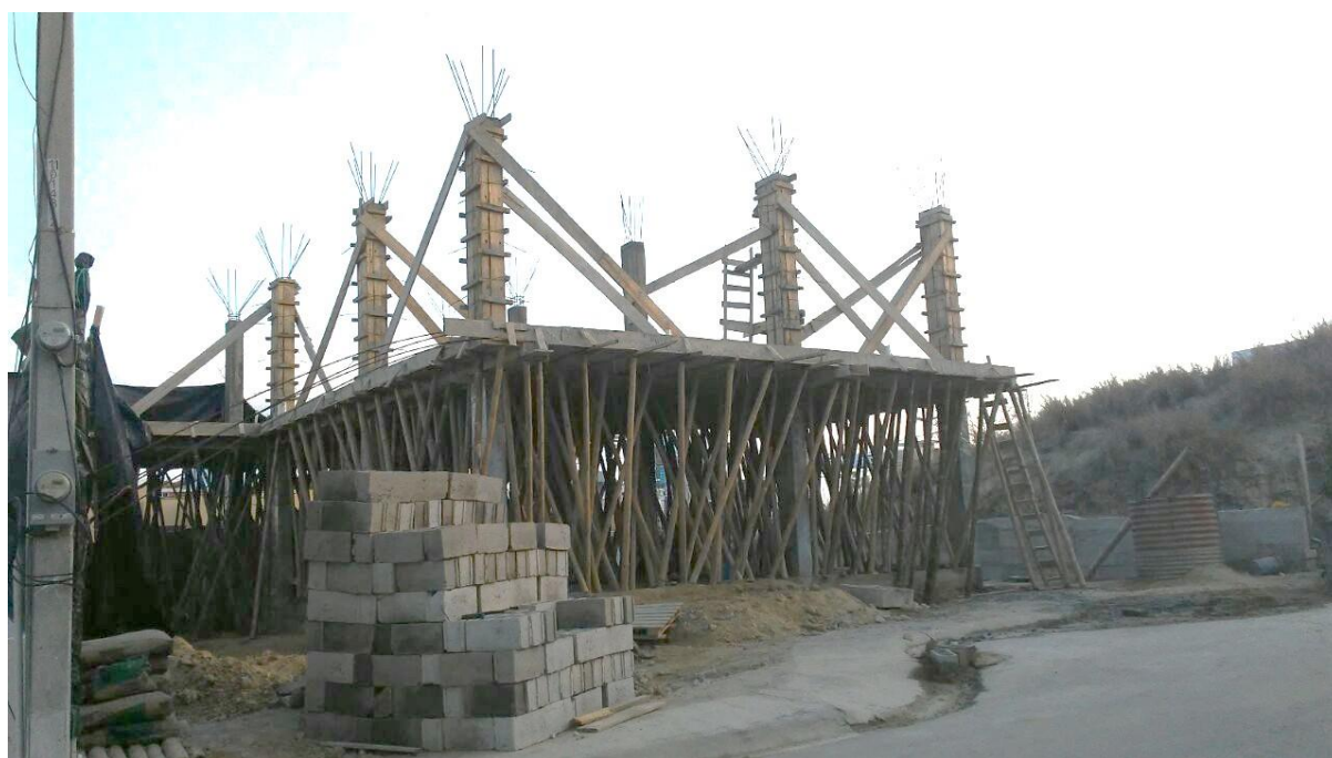
Gráfico No. 26. Encofrado de columnas en segunda planta. Vivienda Familia Vélez - Moreira. (2019).
