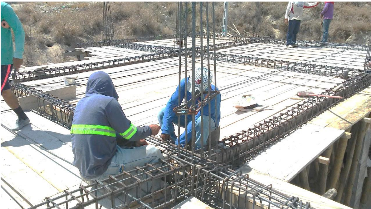
Gráfico No. 24. Armado de vigas y columnas en planta alta. Vivienda Familia Vélez - Moreira. (2019).
