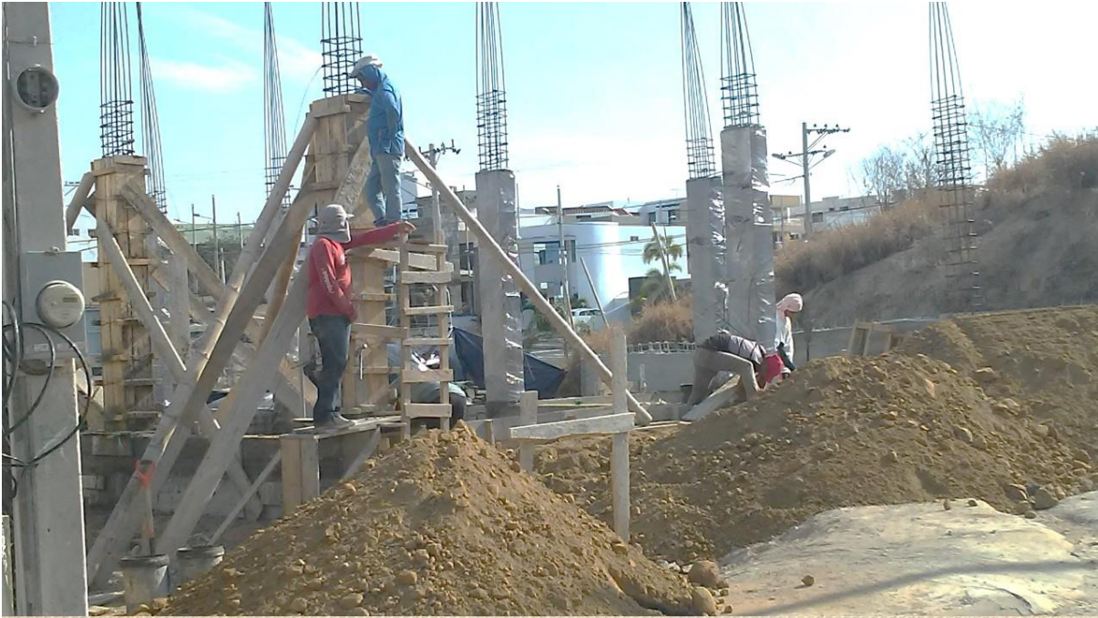
Gráfico No. 23. Encofrado de columnas. Vivienda Familia Vélez - Moreira. (2019).
