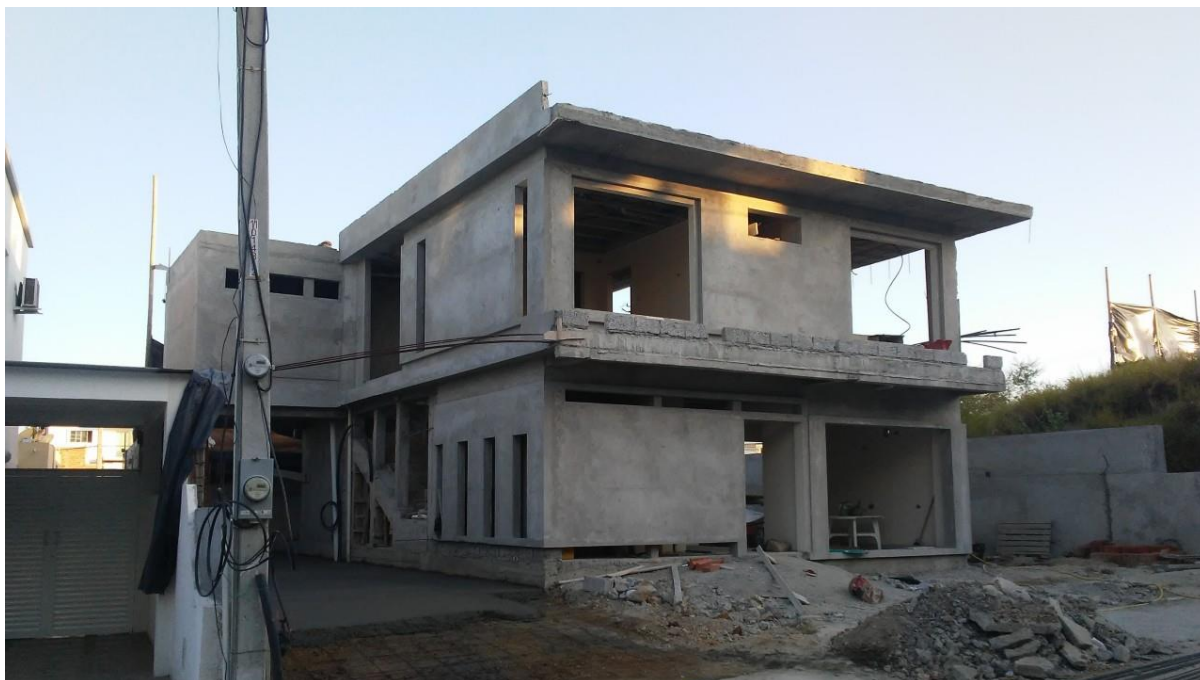
Gráfico No. 31. Vivienda con paredes externas e internas enlucidas. Vivienda Familia Vélez - Moreira. (2019).
