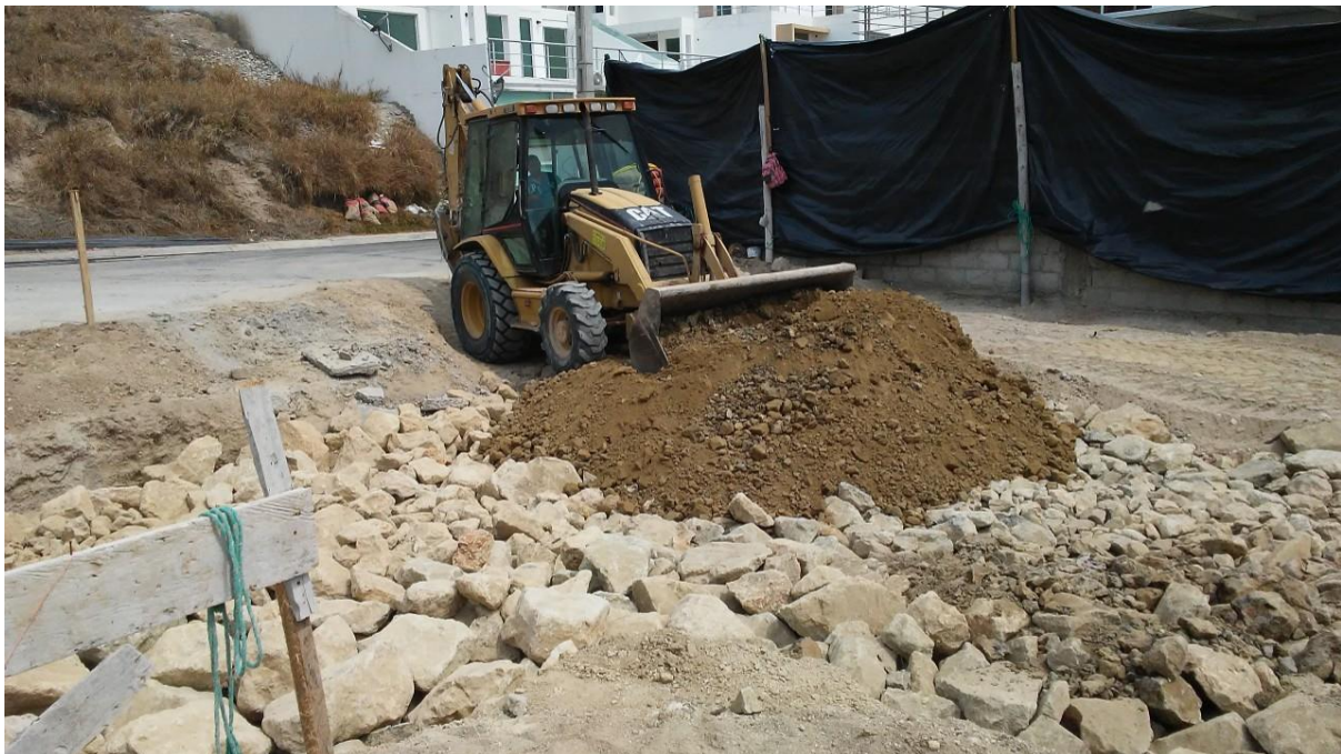
Gráfico No.20. Relleno de material de mejoramiento. Vivienda Familia Vélez - Moreira. (2019).
