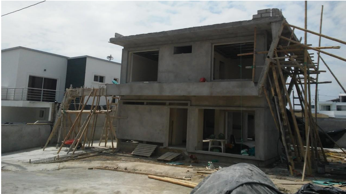
Gráfico No.33. Armado de la estructura para detalle ornamental en fachada. Vivienda Familia Vélez - Moreira. (2019).
