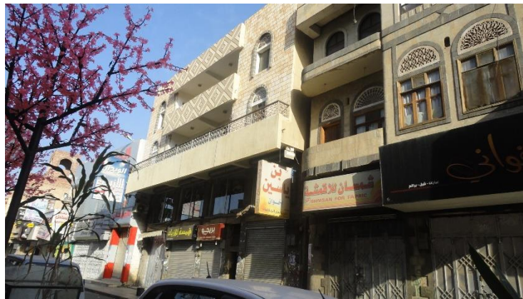
Figura (30) Edificios construidos en Piedra [18]
