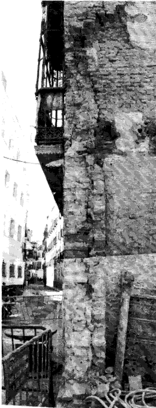
Figura 8 Detalle del muro con las dos hojas en el encuentro con la medianera del núm. 33
