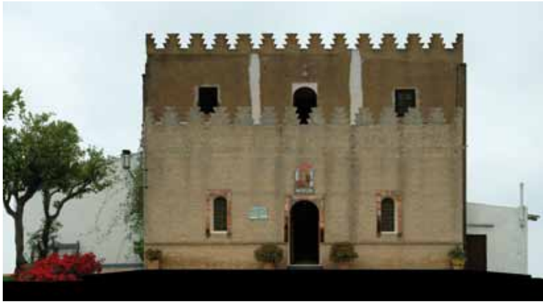
Estado previo, fachada este. Fotomontaje: Tejedor Arquitectos
