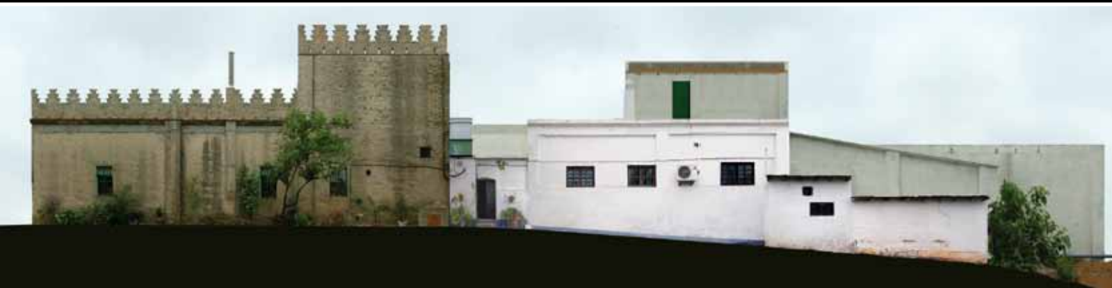
Estado previo, fachada sur (arriba) y norte (abajo). Fotomontaje: Tejedor Arquitectos
