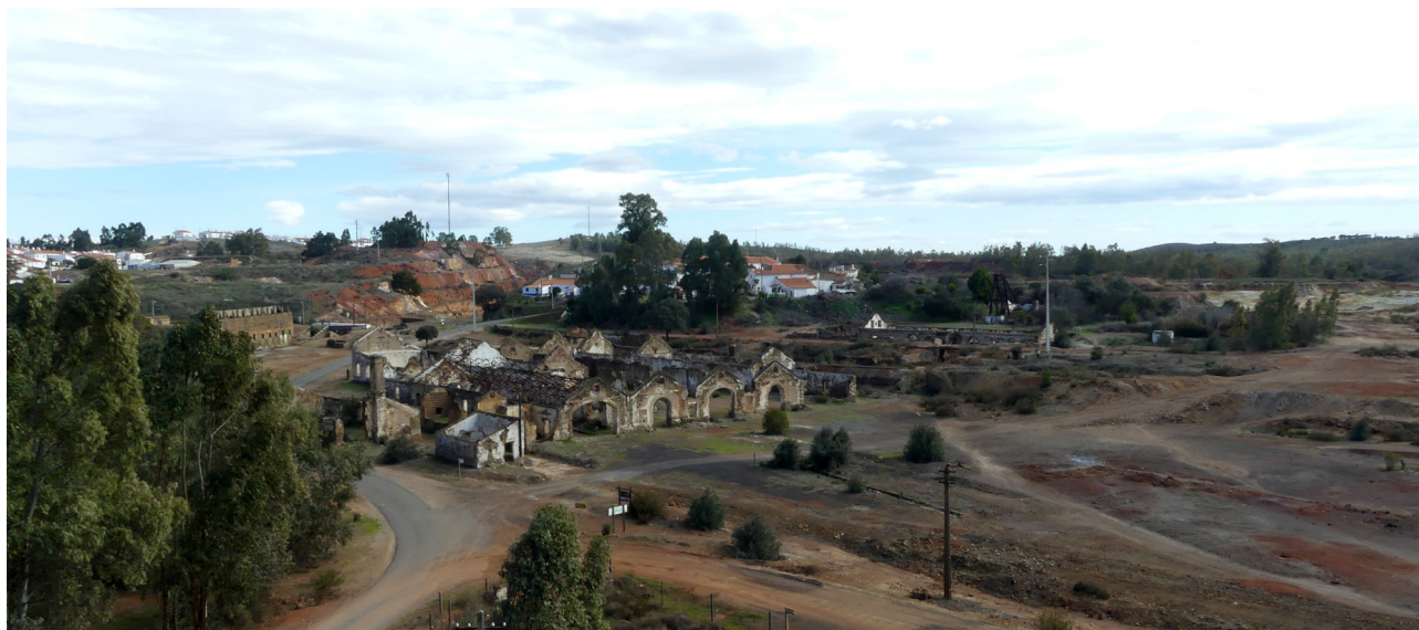
Fig. 4. Imagen panorámica de Mina de São Domingos con las Naves de Talleres Generales a la izquierda y la nave de Almacén de Hierro a la derecha. R. Vioque, 2017.
