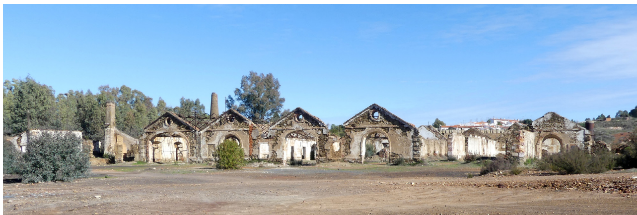
Fig. 5. Imagen general de las Naves de Talleres en Mina de São Domingos. R. Vioque, 2017.
