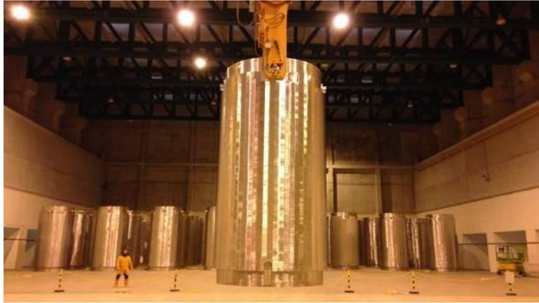
Figura 5.6. Almacenamiento temporal en seco mediante contenedores en la central nuclear de Trillo [102]
