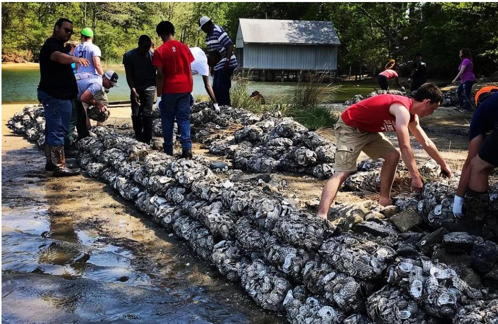
Figura 4.2. Personas construyendo una barrera natural en una costa Fuente: Imágenes de Google
