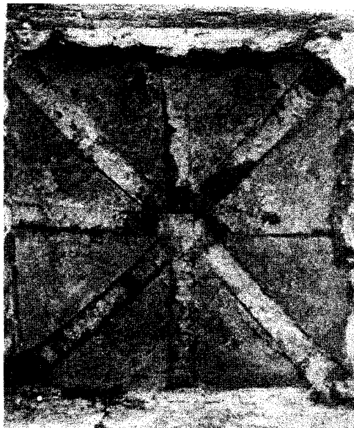
Figura 5 Bóveda de San Millán de la Cogolla de Suso, Logroño
