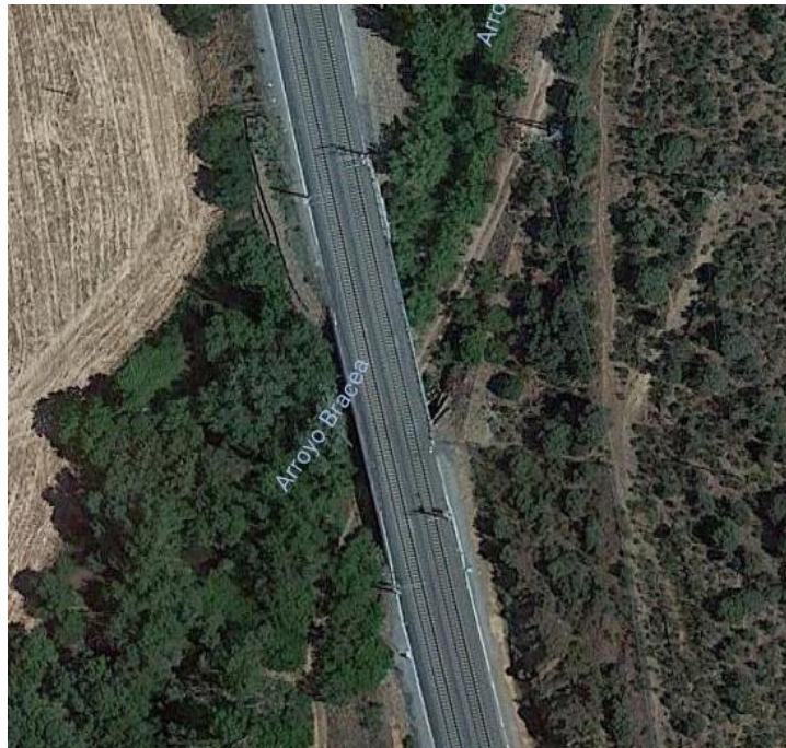
Figura 5-1. Puente Arroyo Bracea (Imagen Google Maps)
