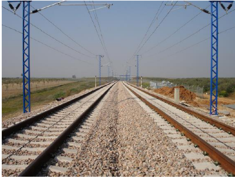
Figura 4-1. Línea de Alta Velocidad Córdoba Málaga. Imagen obtenida de la Ref. [20]
