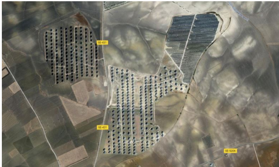
Figura 2.1 Parque fotovoltaico El Coronil.
