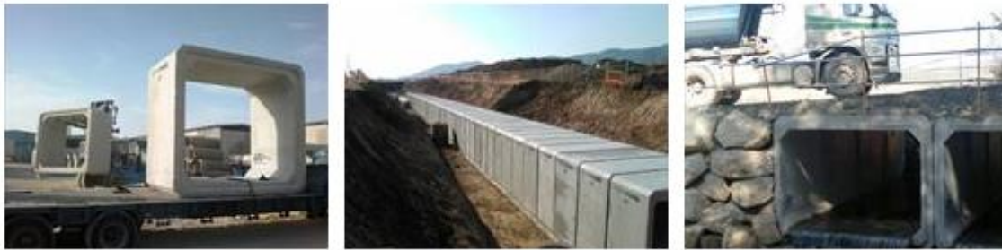
Ilustración 1-2 - Marcos prefabricados de hormigón (GEYSENMARKT)
