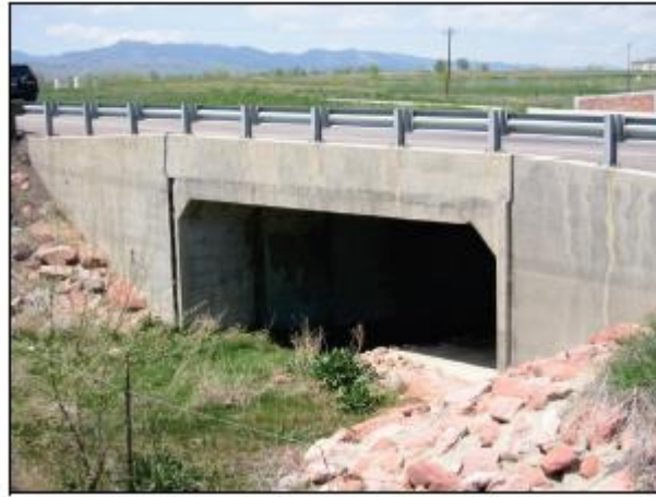
Ilustración 1-1 - ODT rectangular de hormigón
