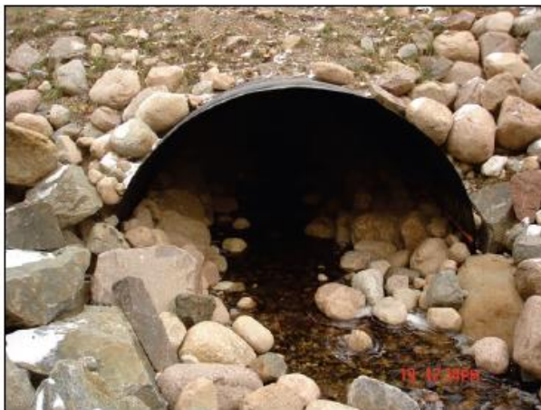
Ilustración 1-6 Ejemplos de ODT especiales para paso de fauna.
