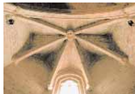
Fig. 3: Vista cenital de la capilla de la iglesia de Sta. María de Morella. Fuente: Propia
