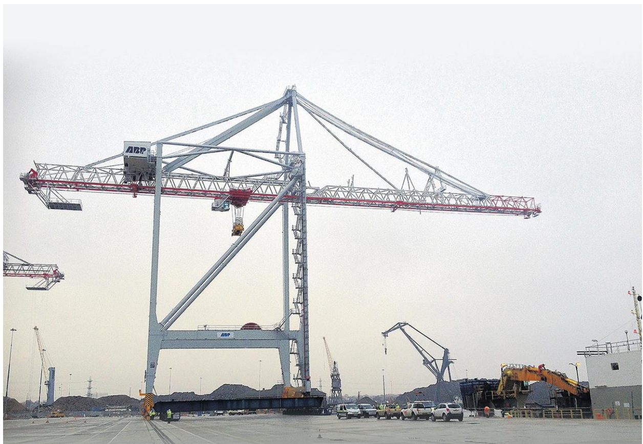
Figura 2: Grúa pórtico de muelle
