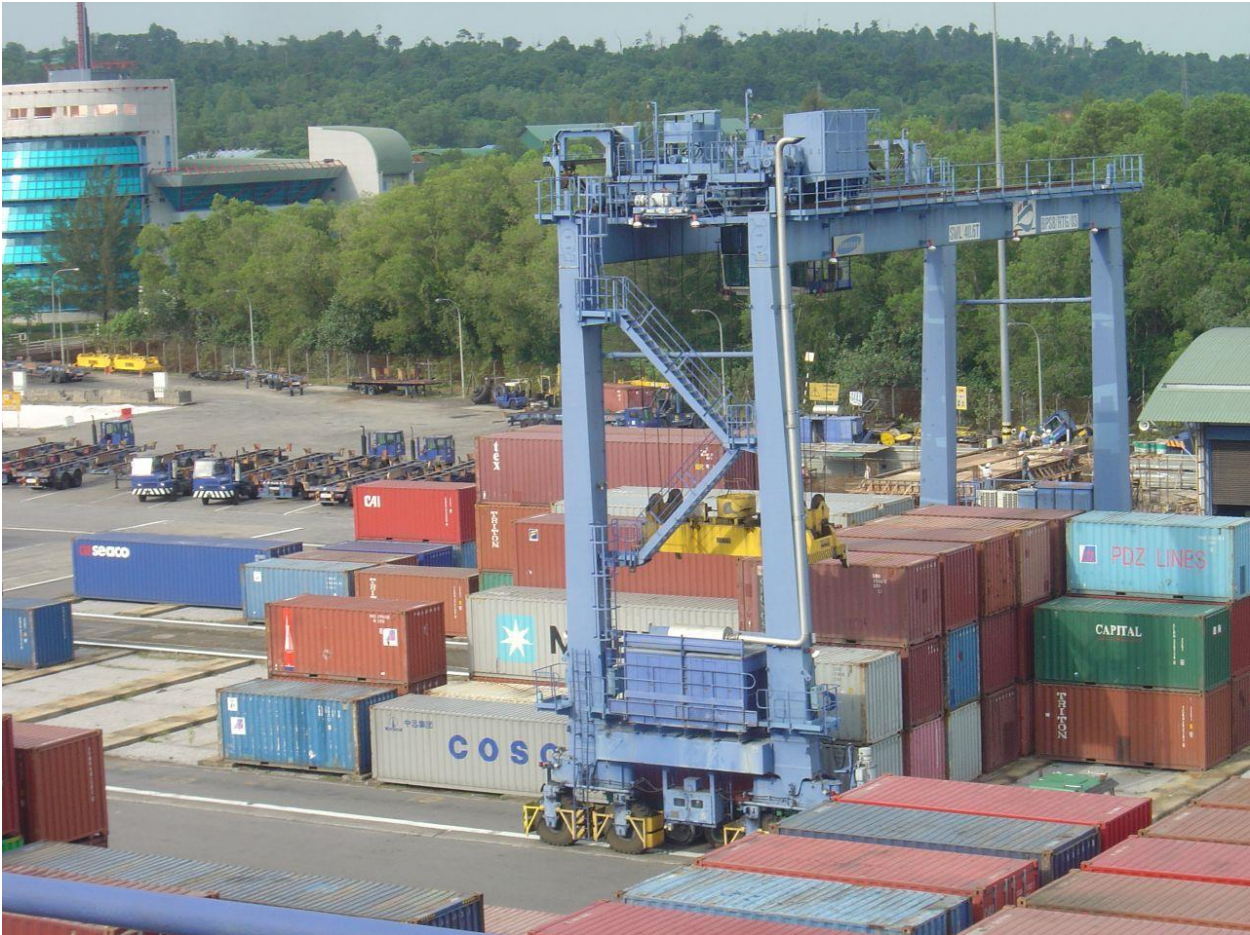
Figura 3: Grúa pórtico con rueda de goma
