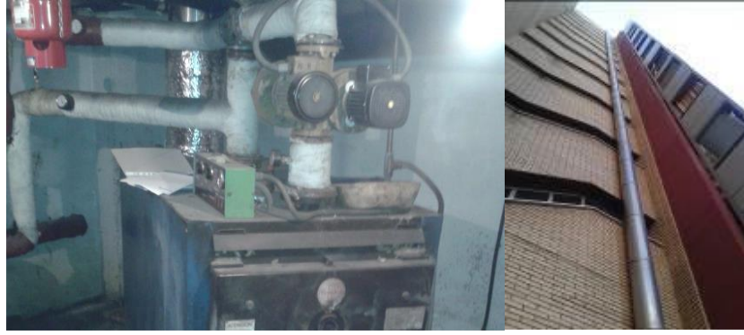
Figura 2.6. Sistema de evacuación de gases.
