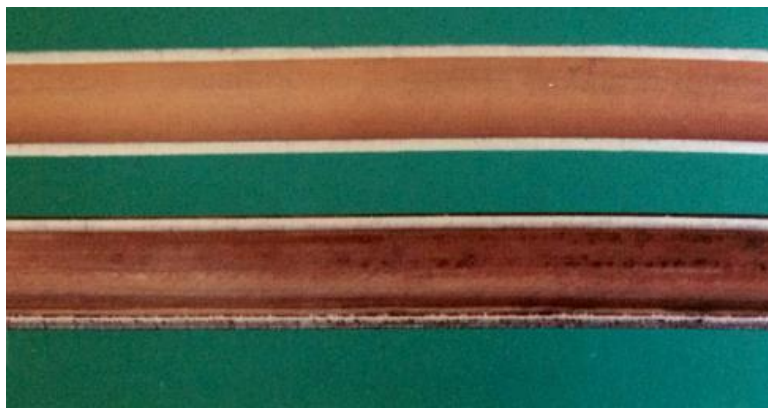
Figura 6.3. Superficie interior de un tubo de acero al cabo de 14 años de operación en un circuito primario.
