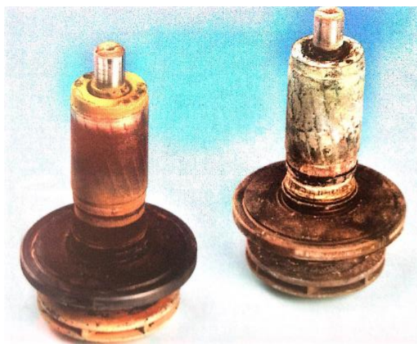
Figura 6.14. Los rotores de dos bombas con sedimentación ligera y fuerte.
