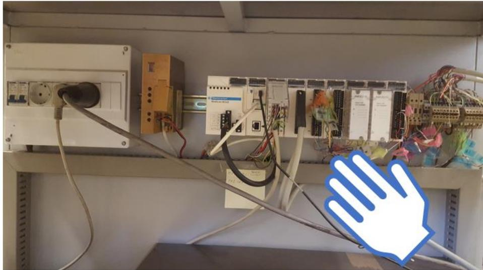
Figura 5-13. Riesgo eléctrico presente en los dispositivos eléctricos ubicados en la parte inferior del puesto de trabajo del brazo robótico SCORBOT.
