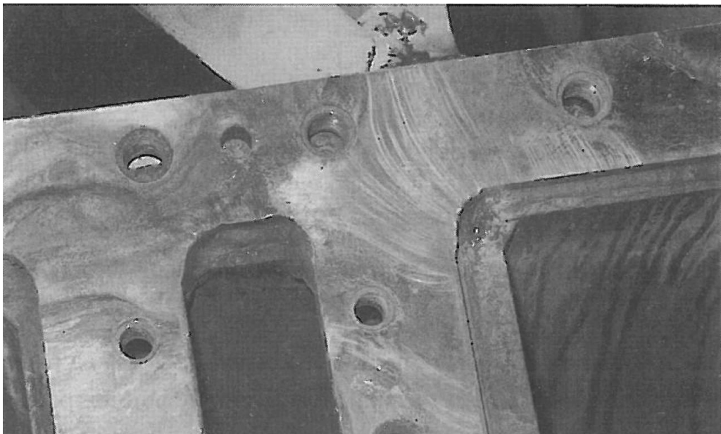
Figura 4.28 Erosion por fugas de agua en una sección de baja presión
