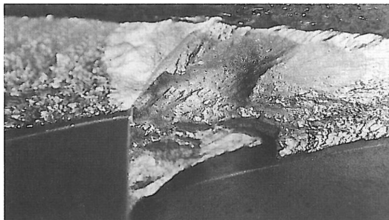
Figura 4.37 Erosión por lavado donde se tiene eliminación de material
