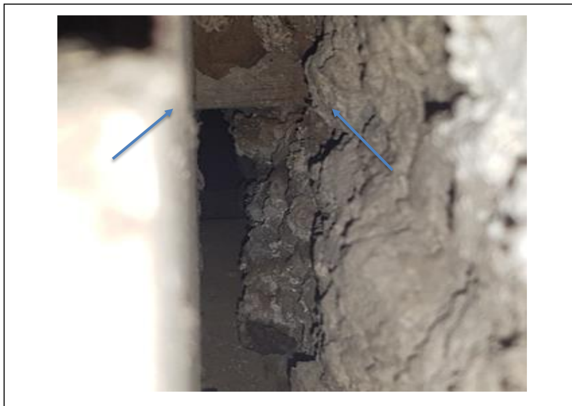
Fig.11, Mechinales de madera adosado al retablo y anclado al muro
