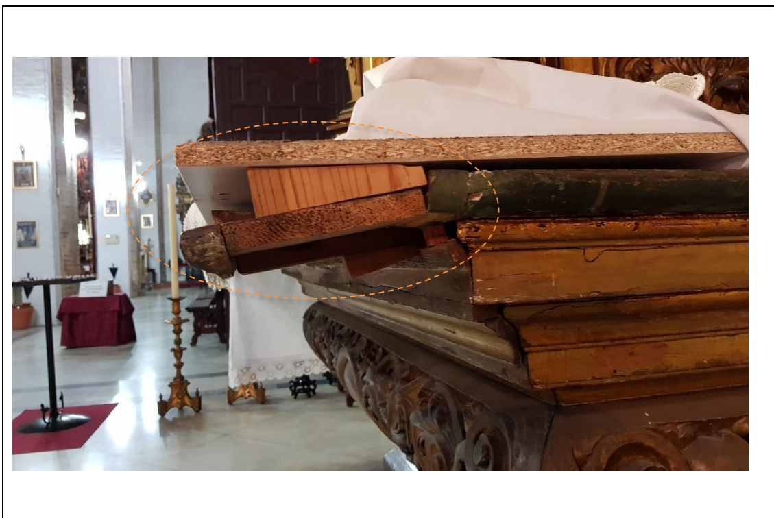
Fig.26. Piezas desplazada ayudada con un calzo para alinear la superficie.
