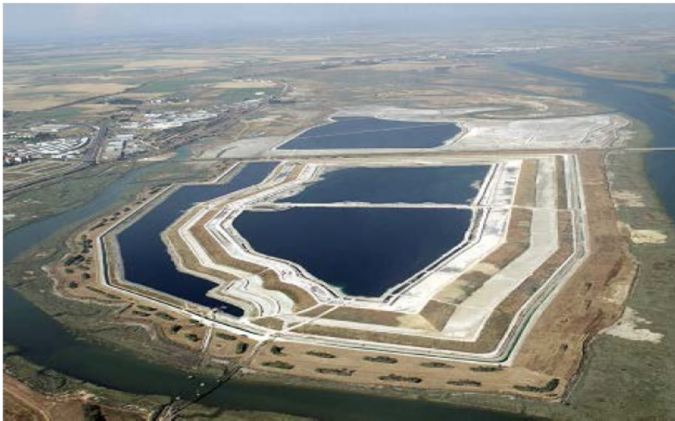
Figura 11: Balsas de acumulación de fosfoyeso en Huelva. 46
