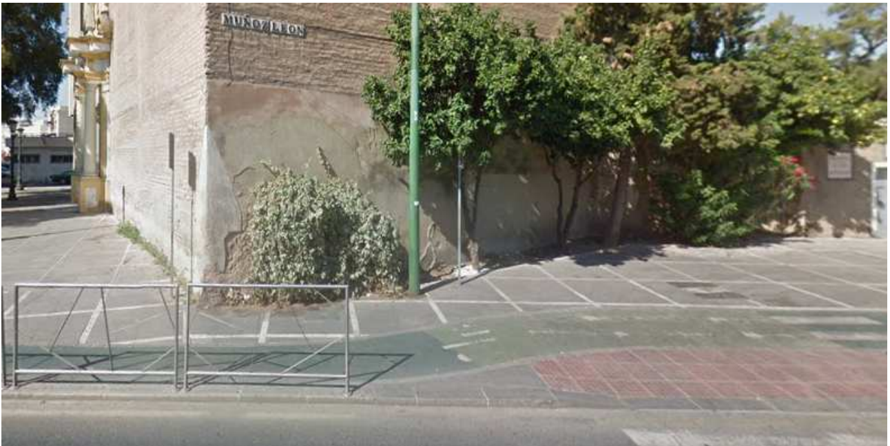
Imagen 7. Circunvalación de San Hermenegildo en la Calle Muñoz León. Previamente el acerado era mucho más estrecho y era ocupado en su totalidad por un angosto carril-bici que lindaba con la esquina sobresaliente del edificio, haciendo imposible el paso de un peatón y una bicicleta al mismo tiempo y propiciando posibles atropellos. El nuevo trazado gana espacio a la calzada, permitiendo un leve desvío del carril-bici y destinando al paso peatonal el espacio que antes ocupaba la vía ciclista. Para la resolución del problema, se mantuvo la angostura del carril-bici. Foto recuperada de Google Maps.
