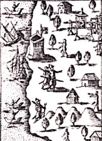
El Alm. se despide del Rey Guacanaum Edificada la Torre de Navidad.
