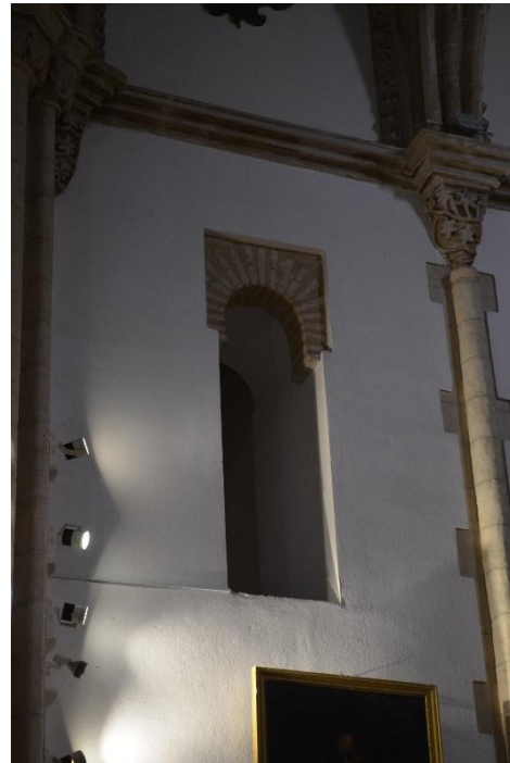
Figura 25. Detalle de vano en el muro del Evangelio en la cabecera de la iglesia de San Andrés. Foto autor.
