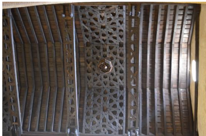
Figura 38. Detalle de la cubierta de la nave central de la iglesia de San Esteban. Foto autor.
