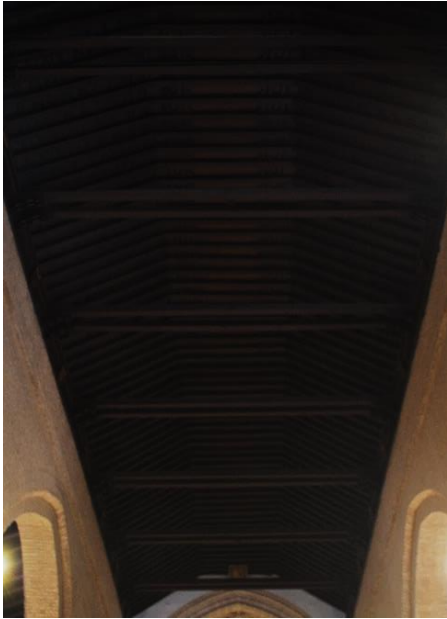
Figura 22. Detalle de cubierta de la nave central de la iglesia de San Andrés. Foto autor.
