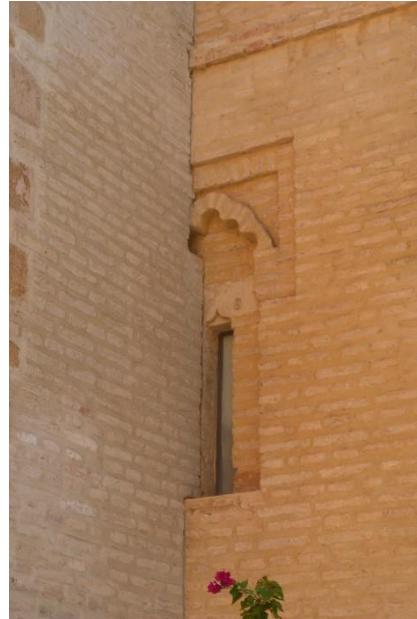
Figura 30. Detalle de ventana saetera. Foto autor.
