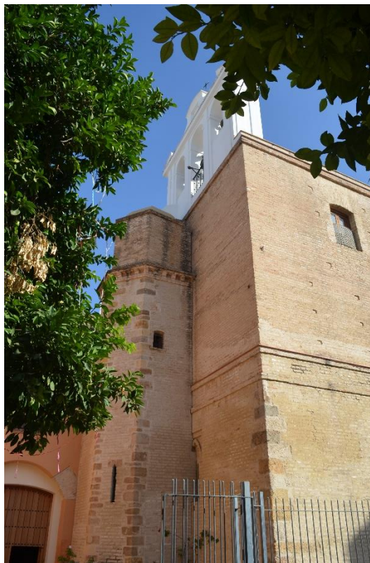
Figura 31. Detalle del exterior y espadaña de la iglesia de San Andrés. Foto autor.
