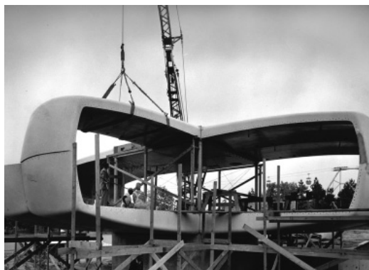
Figura 14 Proceso de montaje de los paneles en obra (Goody Clancy 2017)
