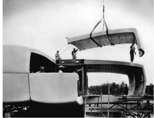
Figura 13 Proceso de montaje de los paneles en obra (Goody Clancy 2017)
