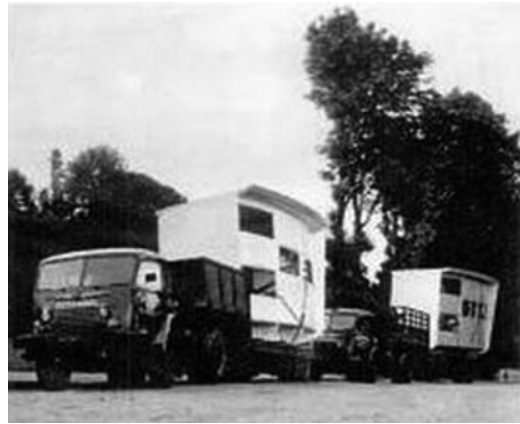
Figura 2 Transporte de los módulos en camiones (Bergdoll et al. 2008)
