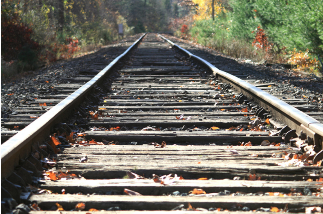
Figura 2.2: Fotografía de una vía.
