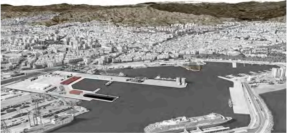
Dársena pesquera. Dique seco. Vista aérea.
