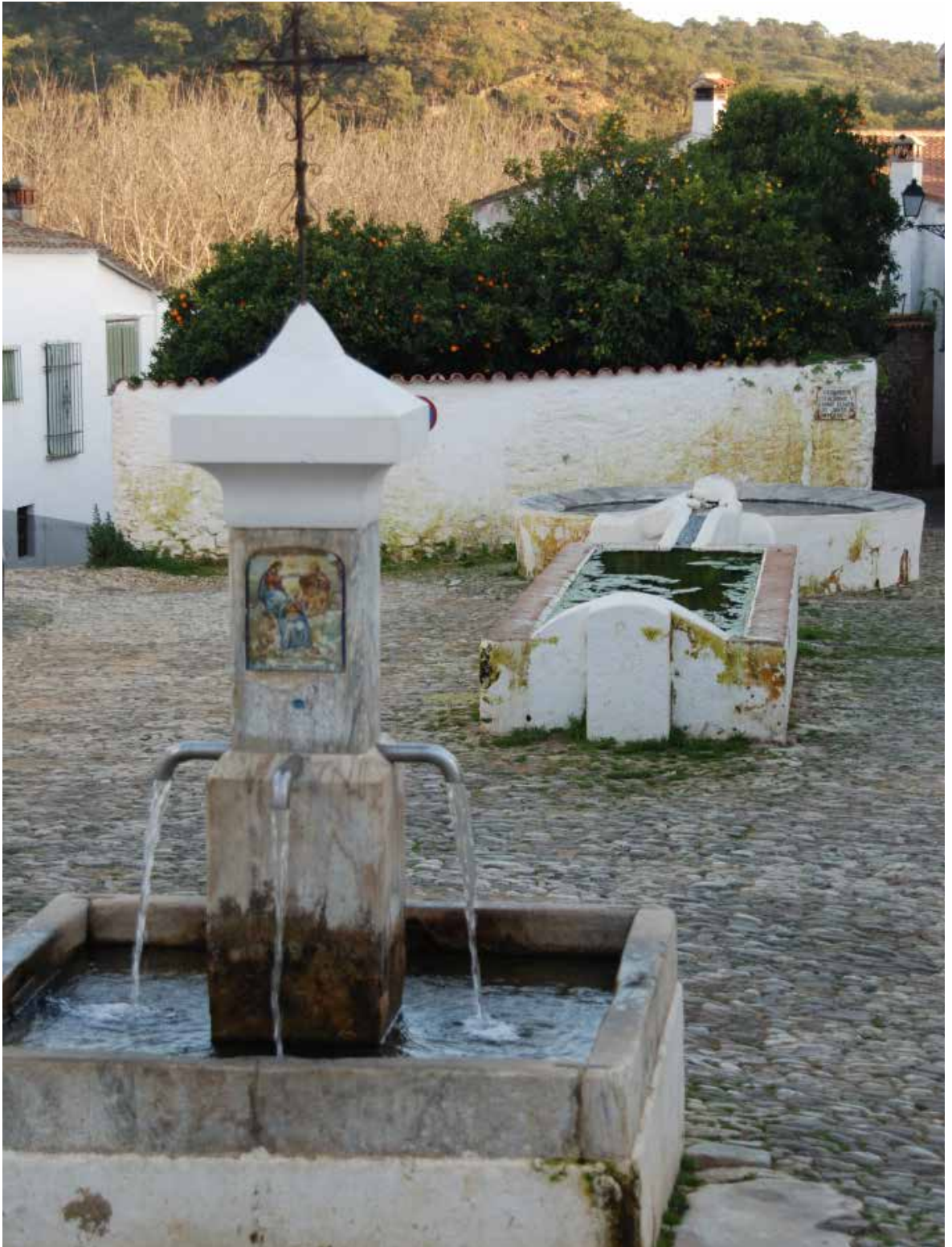
Complejo hidráulico de fuente, lavadero y abrevadero en Linares de la Sierra (Huelva). Usos y aprovechamientos del agua. Fotografía: Aniceto Delgado.
