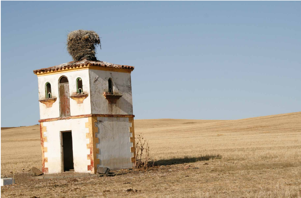
Valencia del Ventoso. Derroches estéticos en una arquitectura funcional. Fotografía: Aniceto Delgado. Inventario de arquitectura vernácula extremeña.
