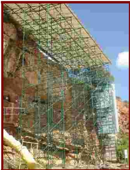
Andamio tubular, ubicado en la zona denominada "Trinchera". Apoyo para diversas plataformas de trabajo.
