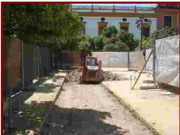
Inicio de la excavación para retirada de capa superficial por medios mecánicos
