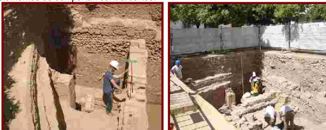
Las fotografías tomadas durante las excavaciones ejecutadas en el Patio de Banderas, de Sevilla, muestran dos situaciones diferentes en las que se aprecia como los muros de las antiguas construcciones hacen las funciones de contrafuerte sobre los laterales de las excavaciones, asegurando su estabilidad.
