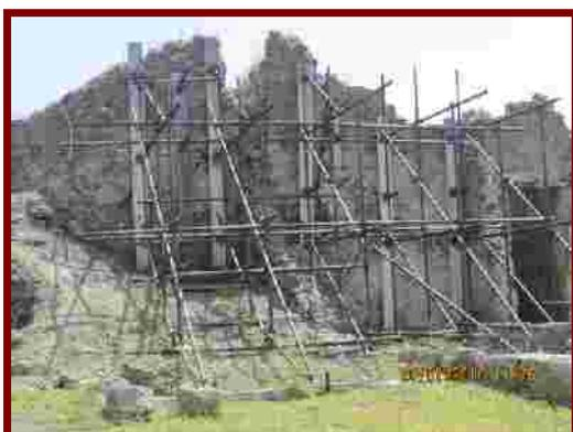
Las estructuras provisionales<sup>176</sup> utilizadas son de porte variable, se encuentran desde las más sencillas para consolidar elementos constructivos aislados hasta algunas complejas para consolidar edificios y soportar cubiertas, también provisionales. Igualmente puede decirse – como se aprecia en las imágenes – respecto a los materiales utilizados: unos son de madera y otros tubulares.
