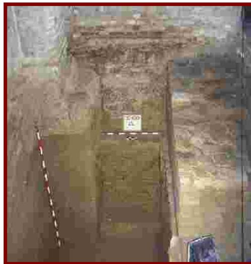
Sistema de cimentación de muro de la Torre de D. Fadrique (asiento de cal, zapata de ladrillo y argamasa)
