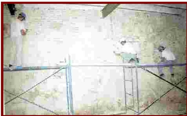
Proceso de rejuntado de sillares con mortero de cal con auxilio de andamios tubulares.
