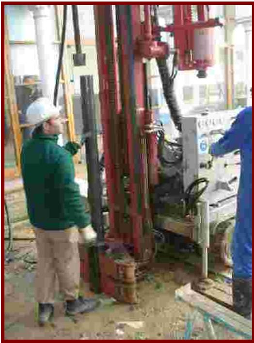
Imagen de la toma de muestras en el patio central, interior, realizada mediante máquina de sondeos.
