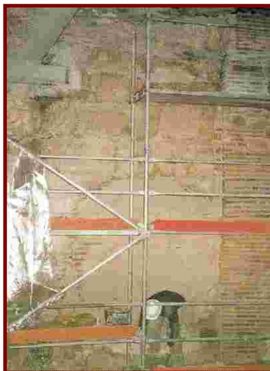
Proceso de eliminación de revestimientos con auxilio de andamios de borriquetas. Igualmente fue preciso el uso de iluminación artificial.
