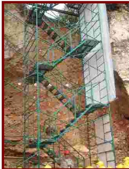
Escalera colocada en un extremo del andamio, para acceso a los diferentes niveles y plataformas de trabajo.
