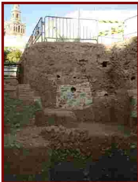
Elementos constructivos que se encuentran enterrados – en este caso macizos de fábrica de ladrillo fijados con morteros de cal – forman núcleos resistentes que potencian la estabilidad de las paredes de las excavaciones.
