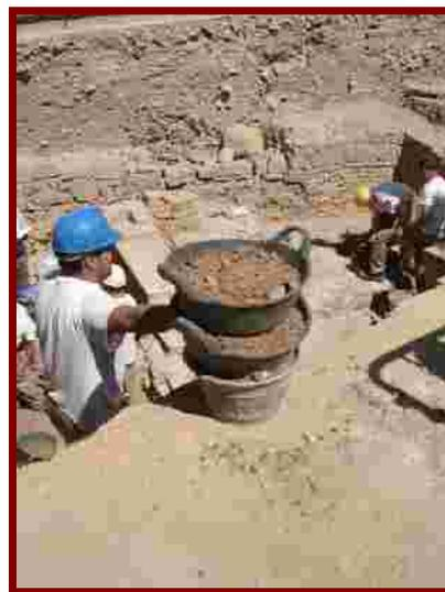
Las tierras desechadas se transportan mediante cubas, colocadas dentro del cajón de obra, para su posterior retirada mediante camión volquete, por parte de la empresa gestora de los RCD.
