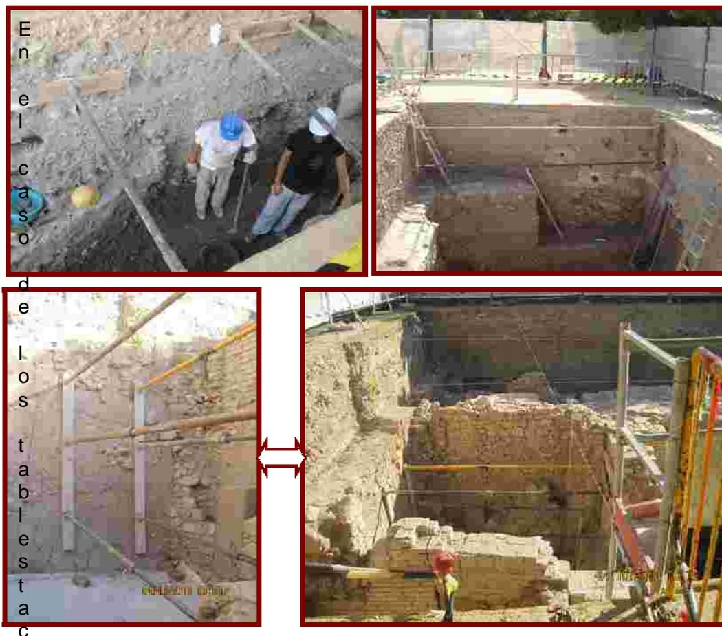
Las entibaciones por puntos pueden ser suficientes para evitar desprendimientos de tierras. Si, además, se complementan con contrafuertes de muros de fábrica (como se aprecia en las cuatro imágenes superiores) el resultado es más que suficiente para evitar derrumbamientos.
