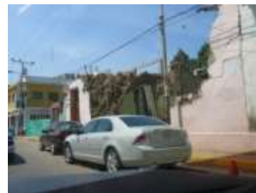
Centro Histórico de Coro después de intensas lluvias. 2011 (Imagen N° 54)
