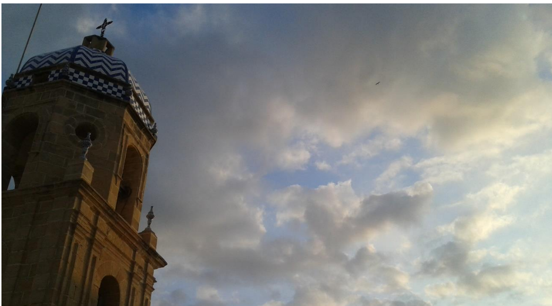
Ilustración 2 Vista de la Torre de la Merced desde la terraza situada en la segunda planta de la sala de exposiciones.
