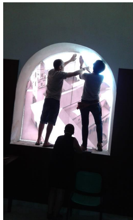
Ilustración 23 Colocación de vinilo cegador de ventanales.
