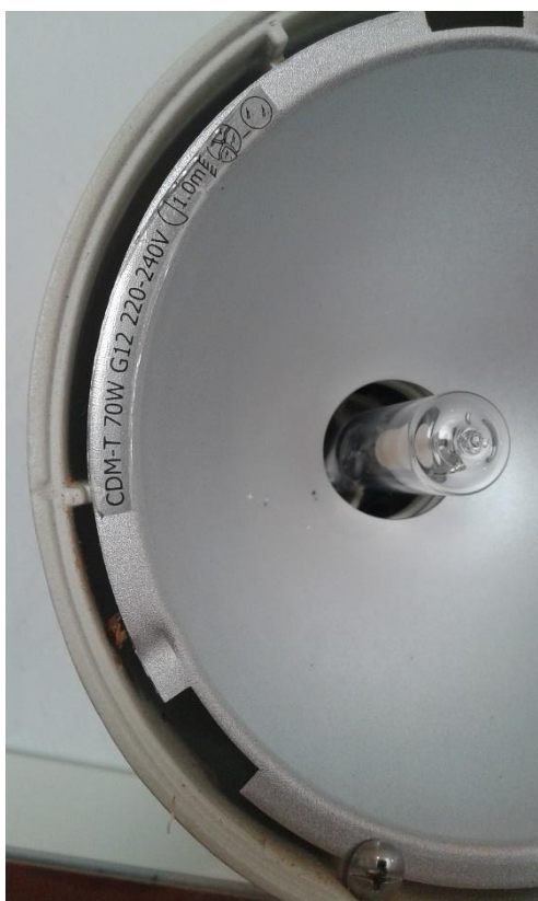
Ilustración 12 Detalle del tipo de foco que alumbra la sala.
