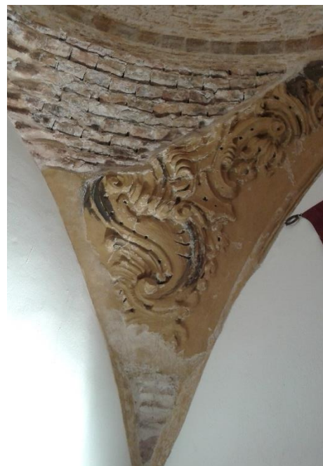
Ilustración 25 Detalle de la decoración original de las pechinas existentes en la sala.
