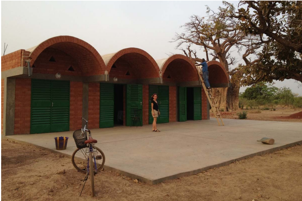
Figura 27. Centro Sociocultural: Casa de la música y de la danza tradicional, Fada N'Gourma (Burkina Faso). Bóveda César González Lobo. Foto: M. Lagos
