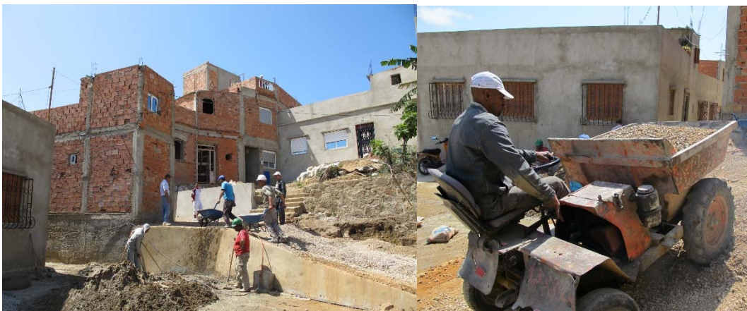
Figura 89. Finalizando las obras. Foto: A. Melo.
