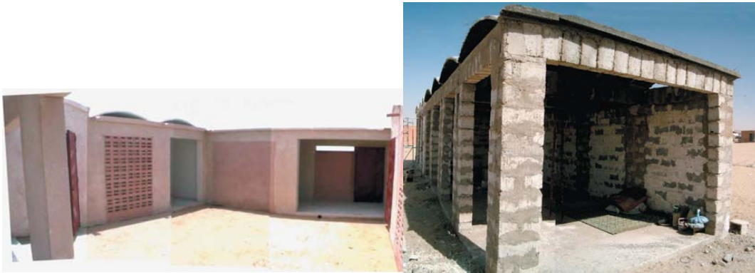
Figura 33. Escuela pública para niños con discapacidad. Nouakchott (Mauritania). Bóveda CGL con materiales reciclados. Fuente: Legarra, Oteiza y Salas (2004)
