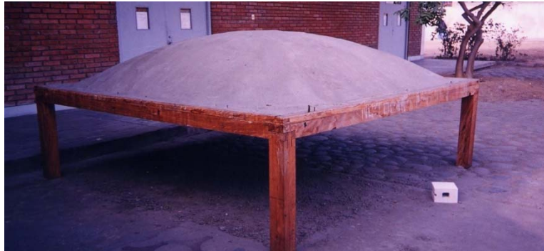
Figura 35. Cubierta en ferrocemento. Foto: A. Melo
