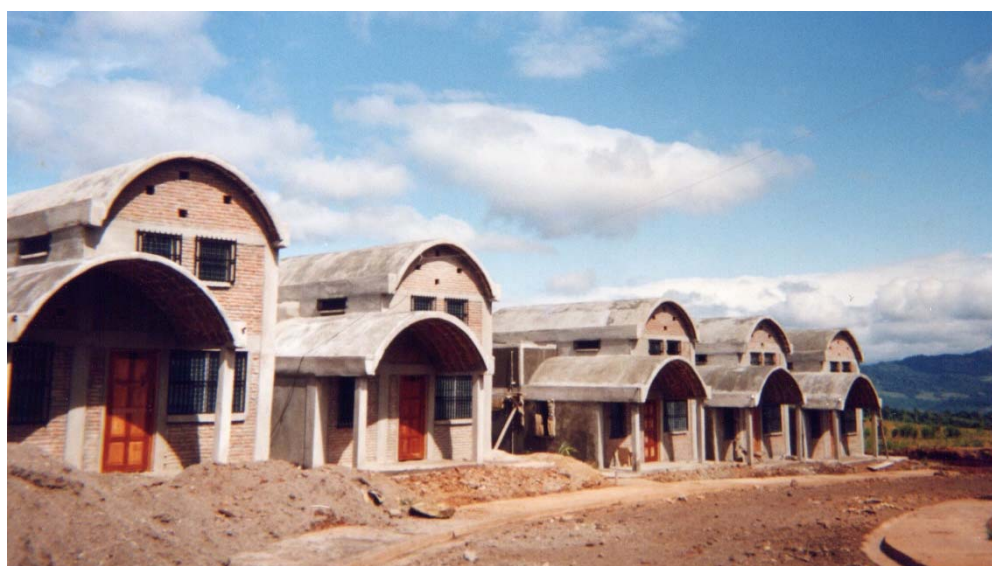
Figura 29. Viviendas en El Tuma, La Dalia (Nicaragua). Bóveda Carlos González Lobo. Foto: A. Melo
