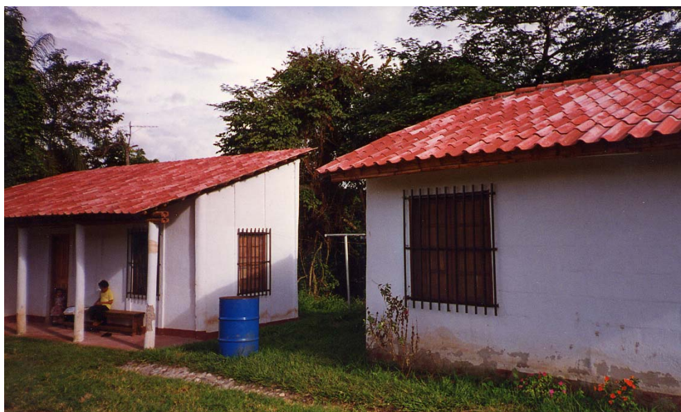
Figura 28. Viviendas con estructura de bambú y cubierta de teja de microconcreto, Escuela Agrícola Panamericana Zamorano (Honduras). Foto: A. Melo
