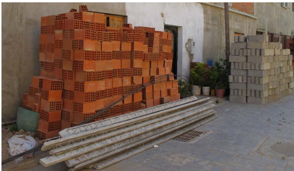
Figura 80. Acopio de materiales. Foto: A. Melo.
