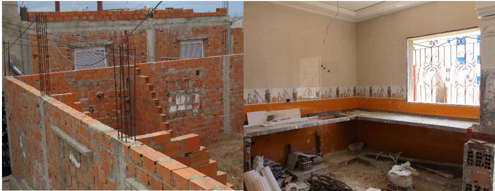
Figura 88. Obras en proceso. Foto: A. Melo.
