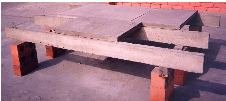
Figura 30. Sistema de prefabricación (en taller o in situ) Vigueta + Plaqueta. Foto: A. Melo
