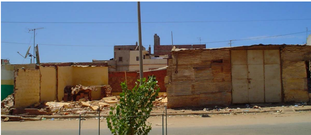
Figura 51. Aplicación del programa Ville sans Bidonvilles en uno de los barrios de Larache. Recasement massif. Foto: A. Melo
