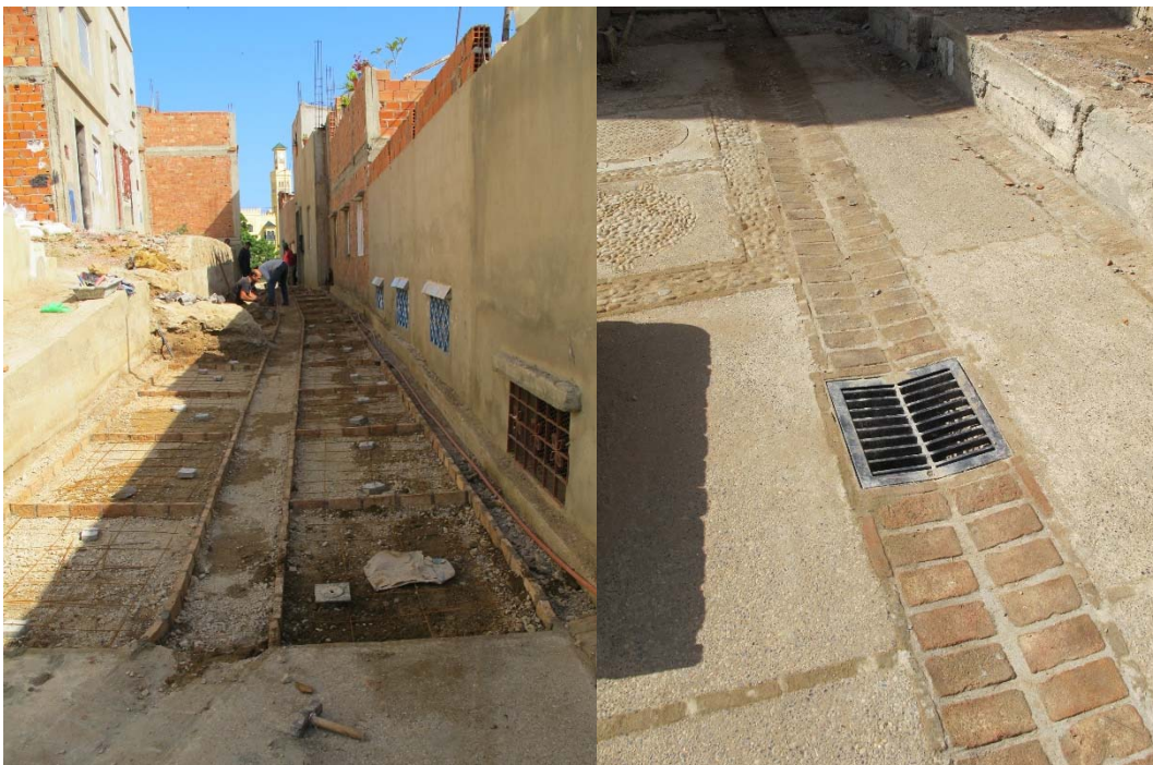
Figura 87. Obras de pavimentación de Jnane Aztout. Foto: A. Melo.
