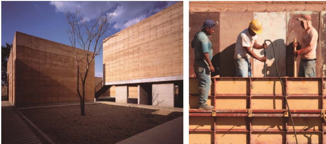
Figura 26. Escuela de Artes Plásticas de Oaxaca (México). Fuente: Taller de Arquitectura Mauricio Rocha (2008)
