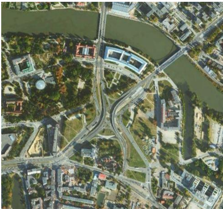
Figura 45. Imagen aérea del cruce señalado en la Figura 42. La zona de museos se encuentra a izquierda de la foto. El edificio de la cubierta azul es el Parlamento de la región de Wrocław.
