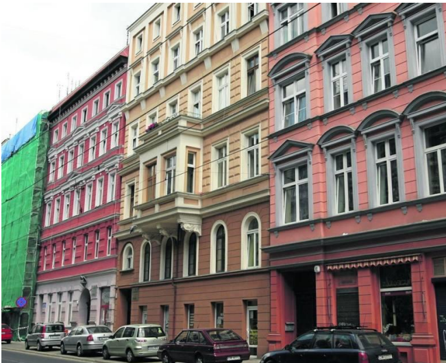
Figura 43: La imagen superior muestra el actual estado de muchas de las fachadas de edificios de la ciudad, irrelevantemente de la zona en la que se encuentren. Y en la parte inferior las fachadas recién restauradas e incluso una en proceso.
