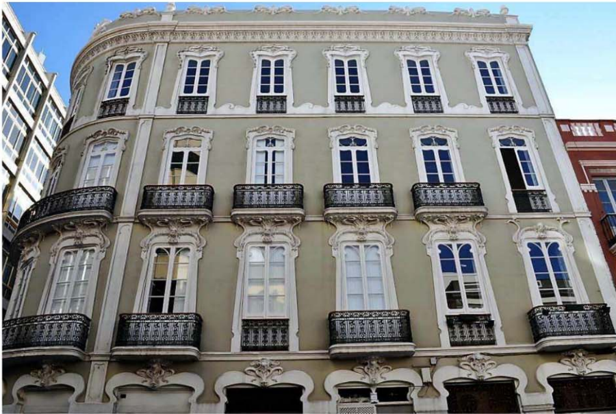
Fig. 4 Modernist building nº 76 of the street Triana. Las Palmas Gran Canaria
