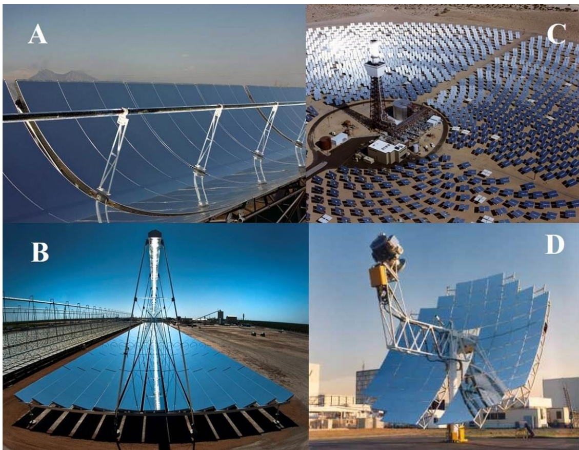
Ilustración 2. Tipos de concentradores solares: A-CCP, B-CLFR, C-CRS, D-DP (Mártil, 2016)
