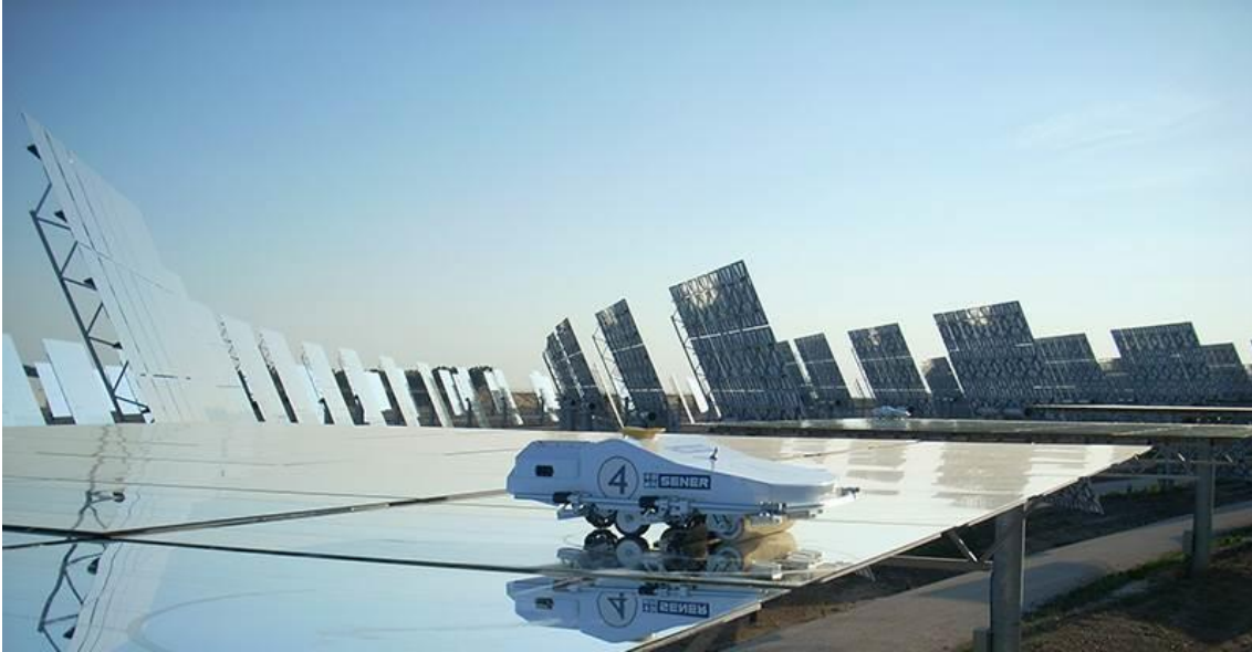
Ilustración 10. Robot limpiando la superficie de un heliostato. (SENER, 2012)
