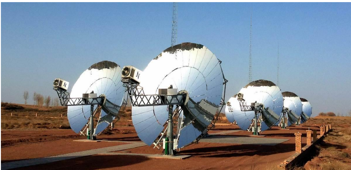
Ilustración 8. Discos Stirling. (Helioscsp, 2015)
