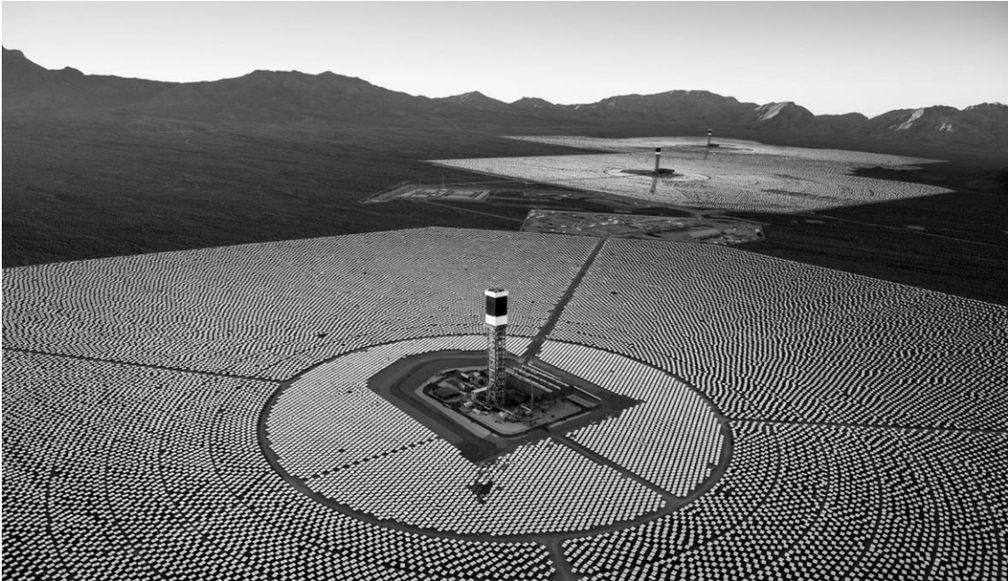
Ilustración 9. Central de receptor central. (Stillings, 2014)
