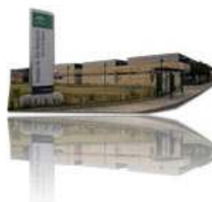
Hospital Sierra de Segura
