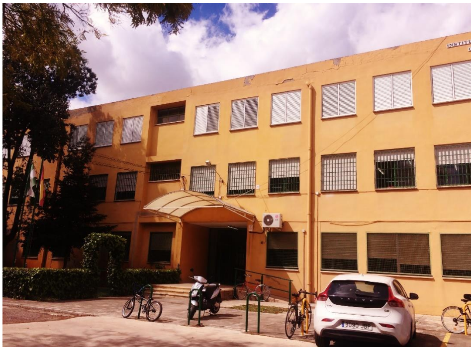
Fotografía del centro tomada el 23-3-2017
