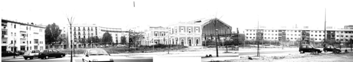
Fig. 10. Estación de San Bernardo de Sevilla. Fotografía Esther Mayoral Campa. 1998.
