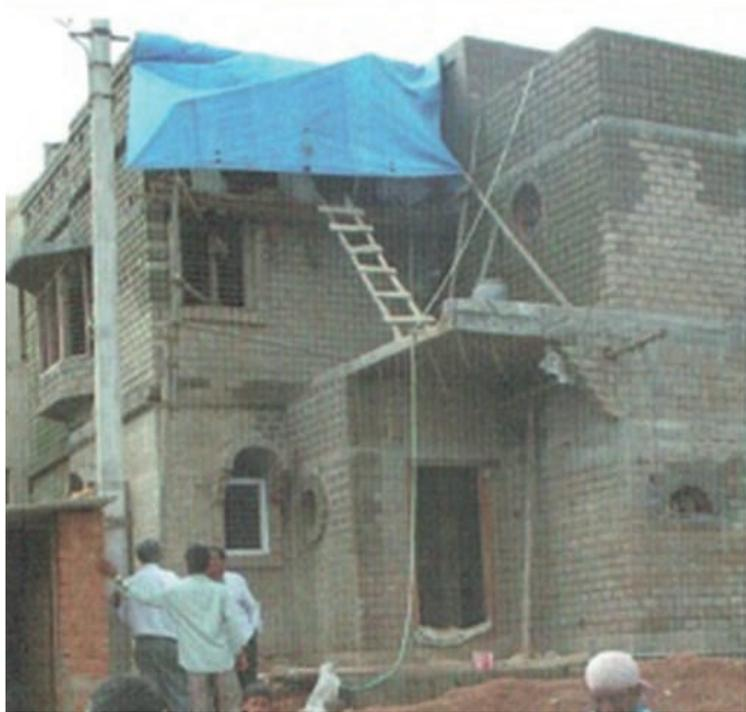
(Fig.1.46) Utilización de BTCE estabilizados con cemento para la realización de viviendas.
