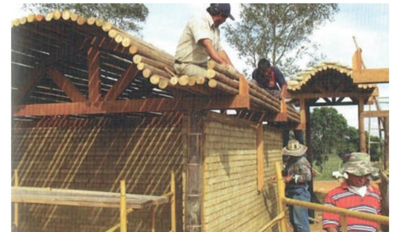
(Fig. 1.43) Adobes reforzados con alambres interiores anti sismo tensados reducidos.
