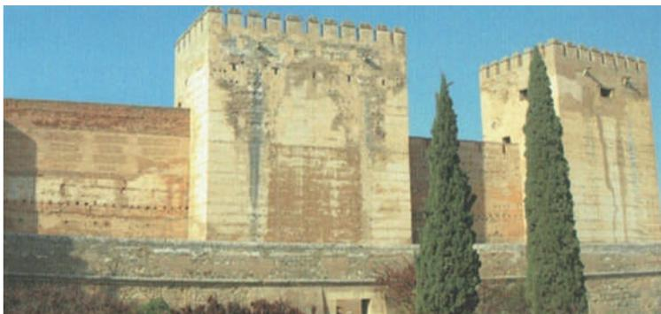
(Fig.2.3) Muros de tapial en el Alcazaba de la Alhambra de Granada.
