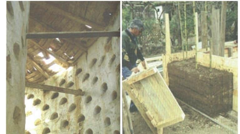
(Fig 1.10) Muros de tapia circulares, con oquedades de travesaños.
