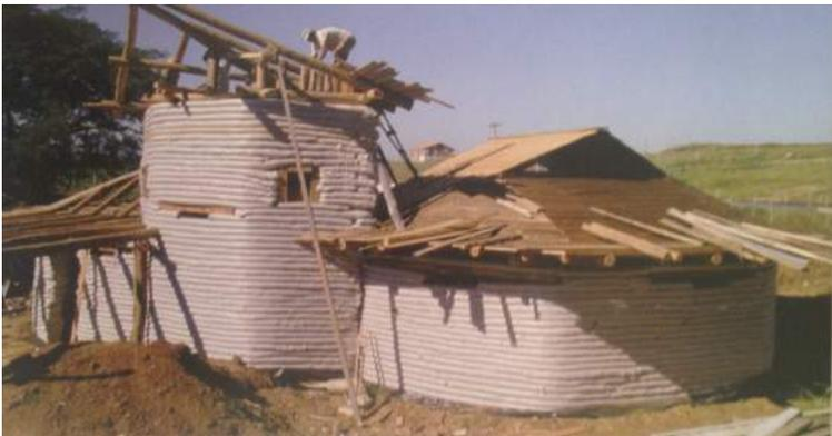
(Fig.1.26) Construcción de ejemplo mediante sacos rellenos
