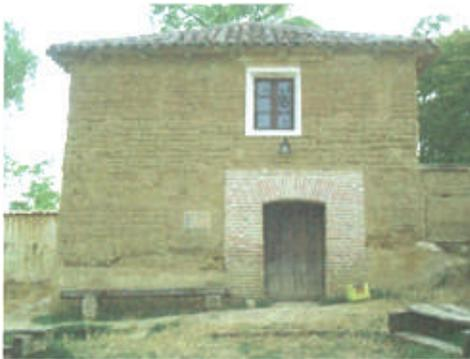
(Fig. 1.7) Construcción tradicional con muros de tapia
