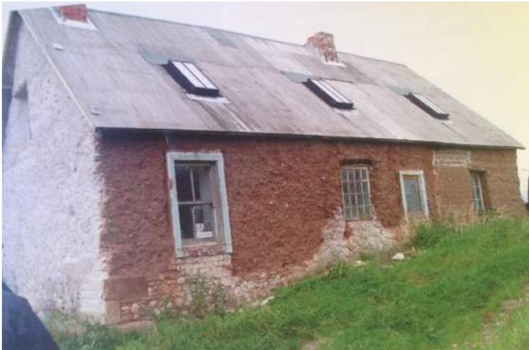
(Fig. 1.14) Vivienda realizada mediante Cob
