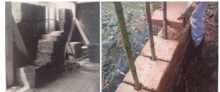
(Fig. 1.40) Muro exterior construido con adobes aligerados con paja;(Fig. 1.42) Adobes antisísmicos reforzados con bambú
