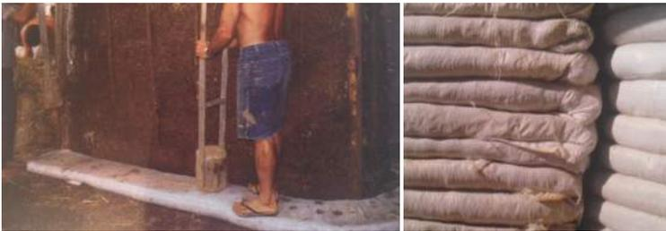
(Fig.1.24) Apisonado y mojado de la saca con el propio material
