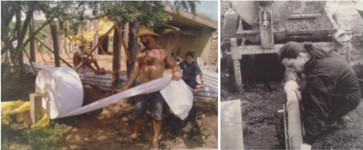
(Fig. 1.22) Sacos de polietileno o tela para rellenar de mezcla
