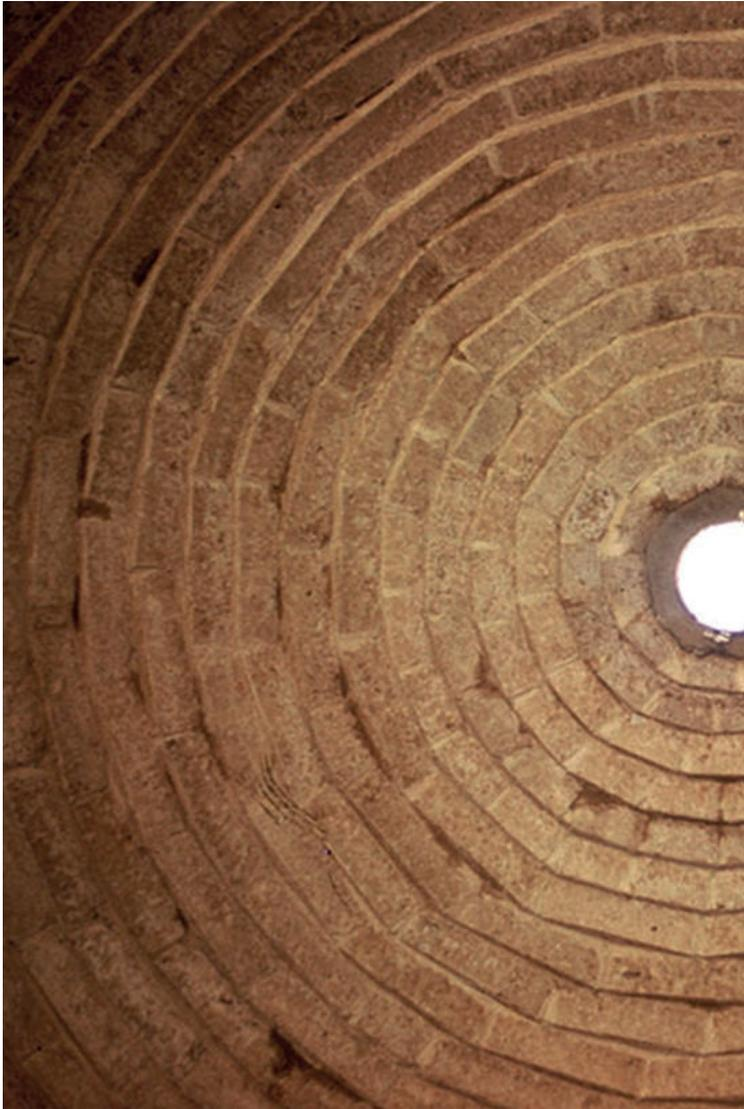
(Fig.4.1) Cúpula construida con BTCE
