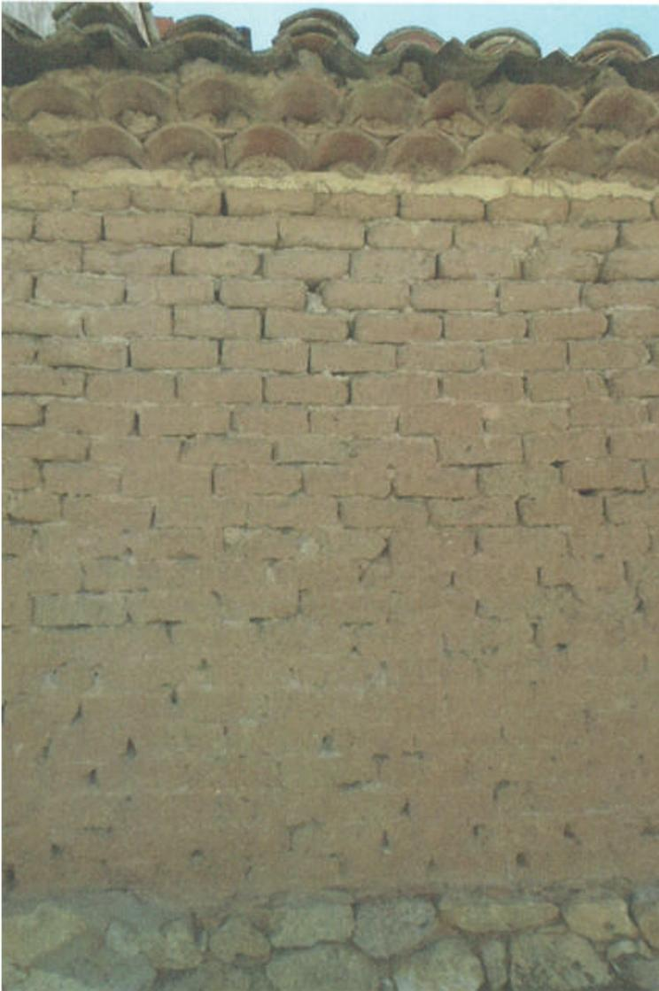
(Fig.0.9) Construcción tradicional realizada con adobe sobre zócalo de piedra
