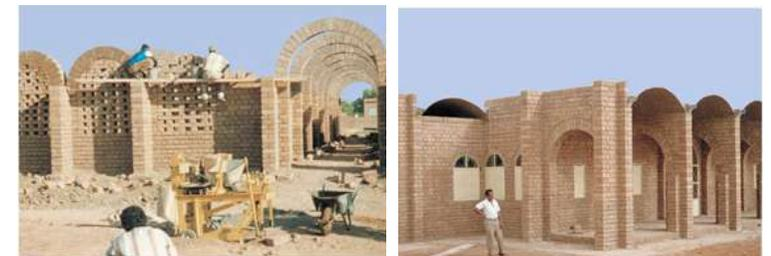
(Fig.3.5) Colegio Haj Yousif School, prototipo y en construcción con BTC estabilizados con cemento
