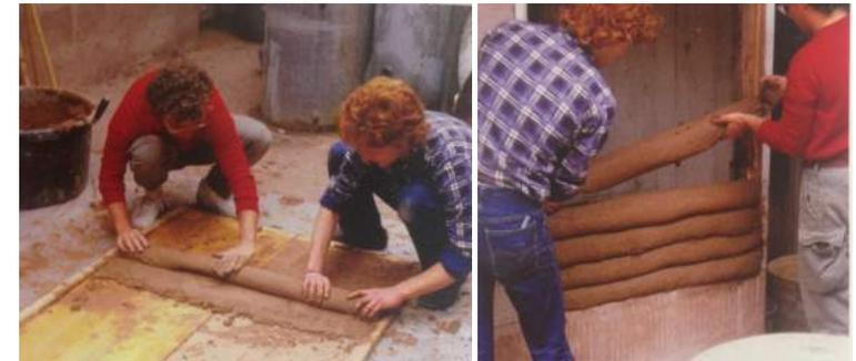
(Fig. 1.29) Enrollado del bambú en la mezcla.
