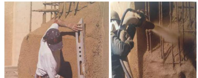
(Fig. 1.31) Nivelación de la mezcla tras la proyección
