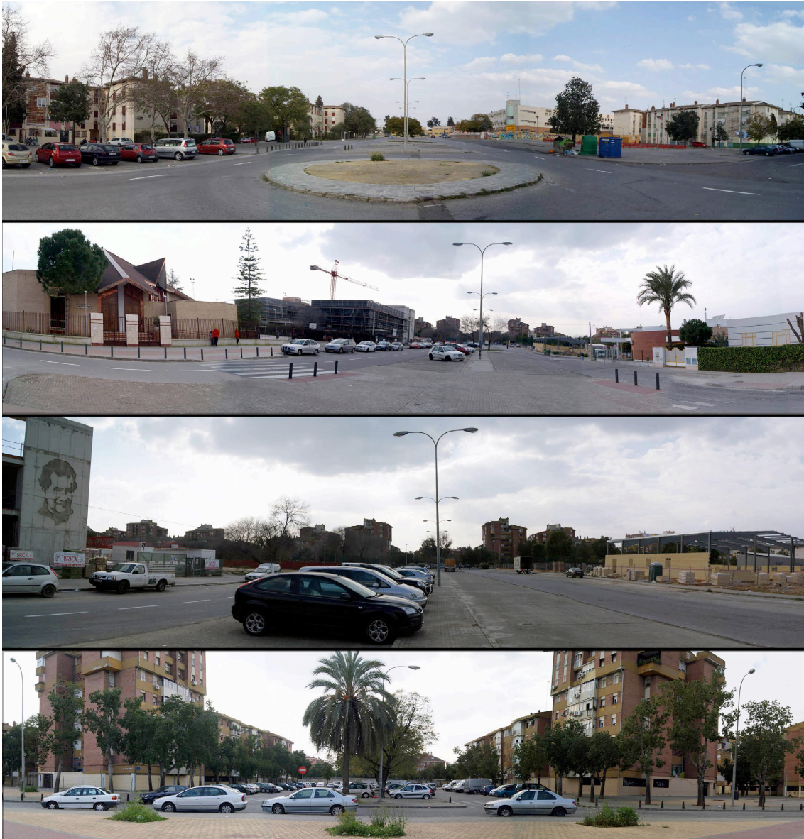
Fig. 03: Estado actual en diferentes tramos de la avenida, espacios públicos degradados e infrutilizados.
